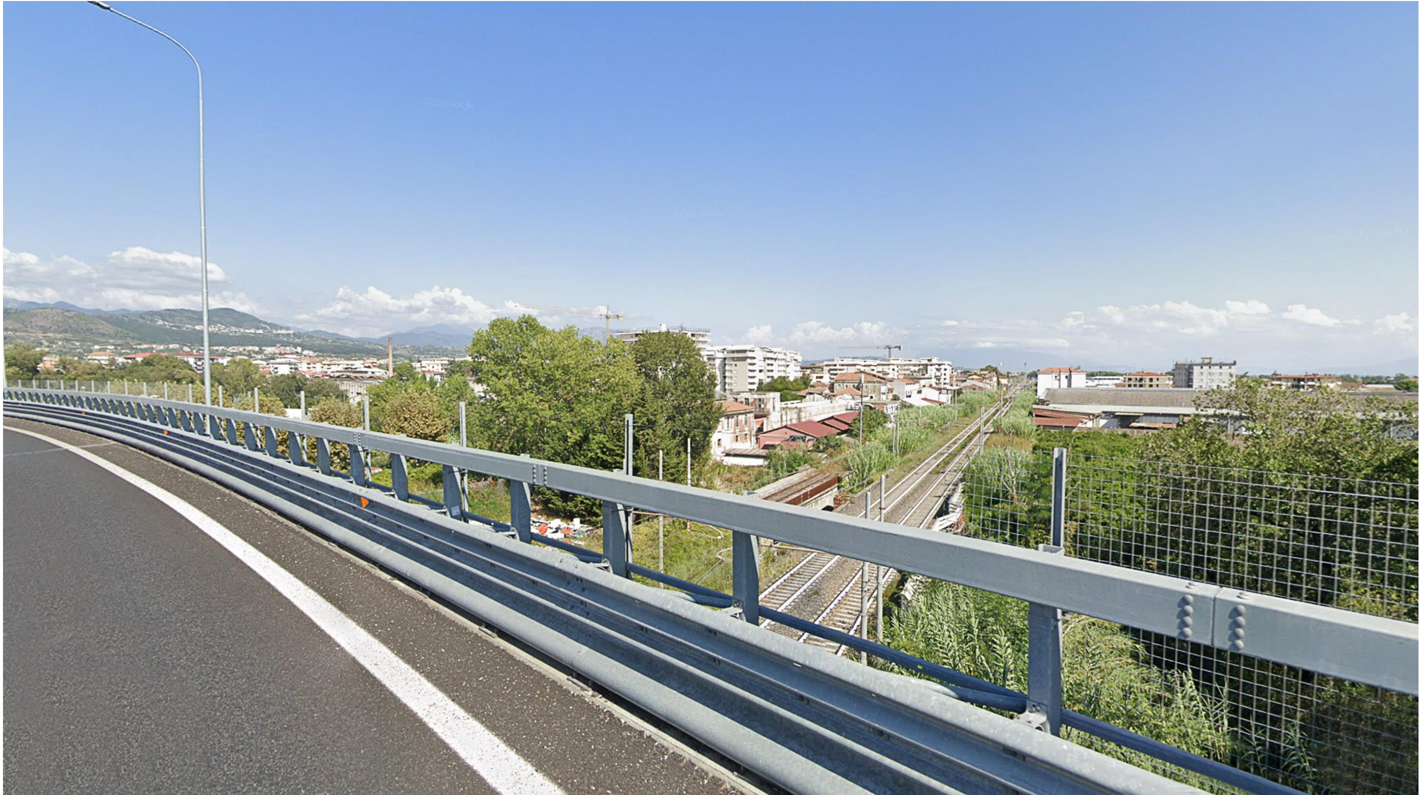
F01 - Ponte Fiume Picentino Km 62+085 LS. Condizioni percettive ante operam
