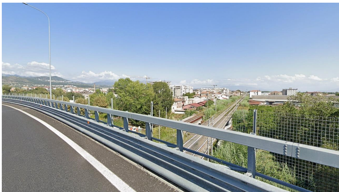
Figura 4-14 Ponte Fiume Picentino Km 62+085 LS. Condizioni percettive ante operam
