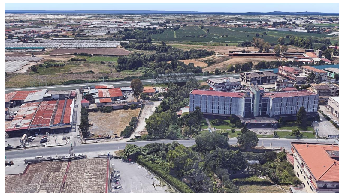
Figura 4-13 Nuovo Ponte Torrente Asa Km 6+860.96. Condizioni percettive post operam
