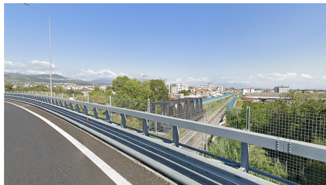
Figura 4-15 Nuovo Ponte Fiume Picentino VI02 Km 3+590.74. Condizioni percettive post operam
