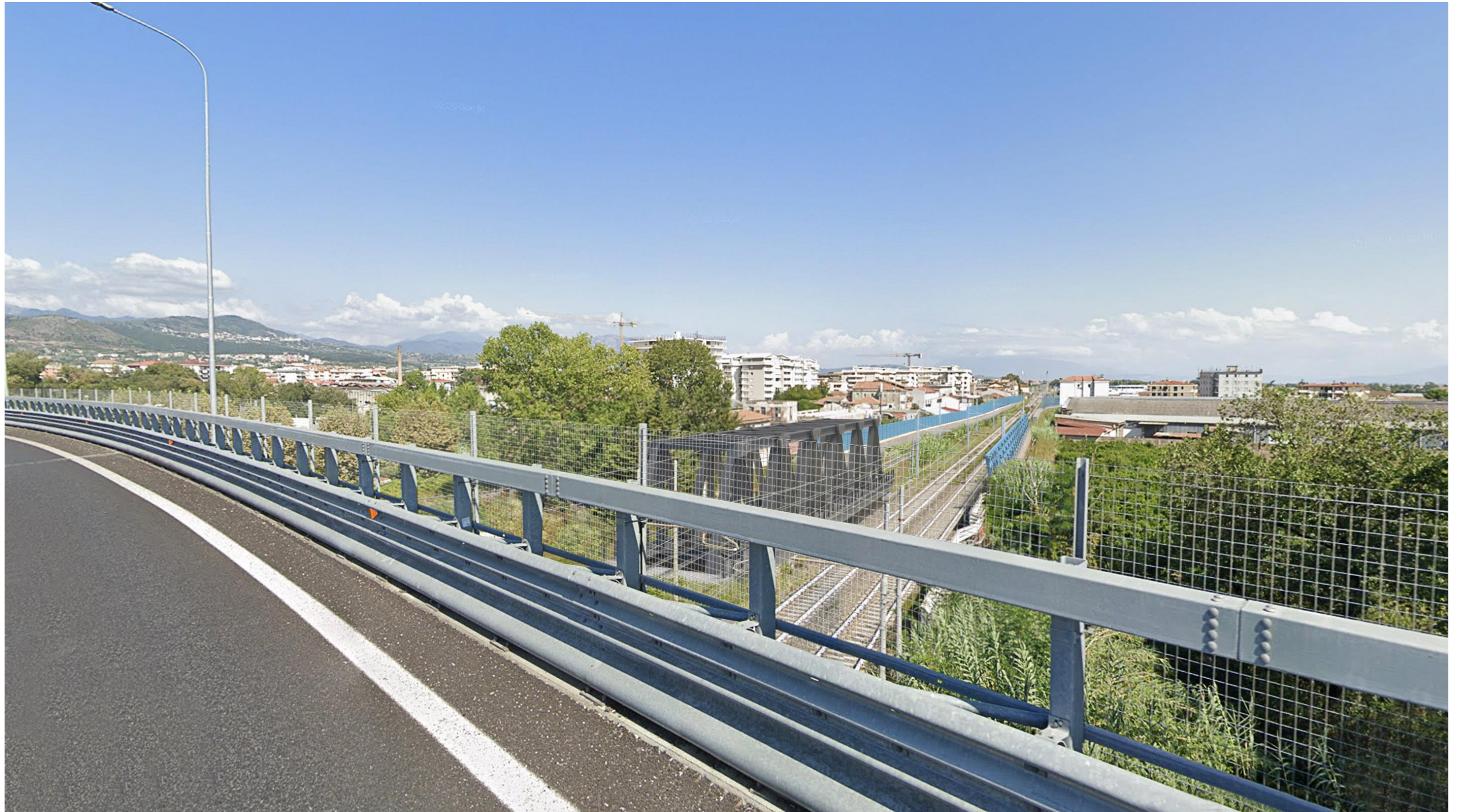
F01 - Nuovo Ponte Fiume Picentino VI02 Km 3+590.74. Condizioni percettive post operam
