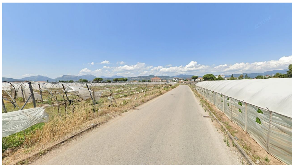
Figura 4-18 Pontecagnano aeroporto. Condizioni percettive ante operam
