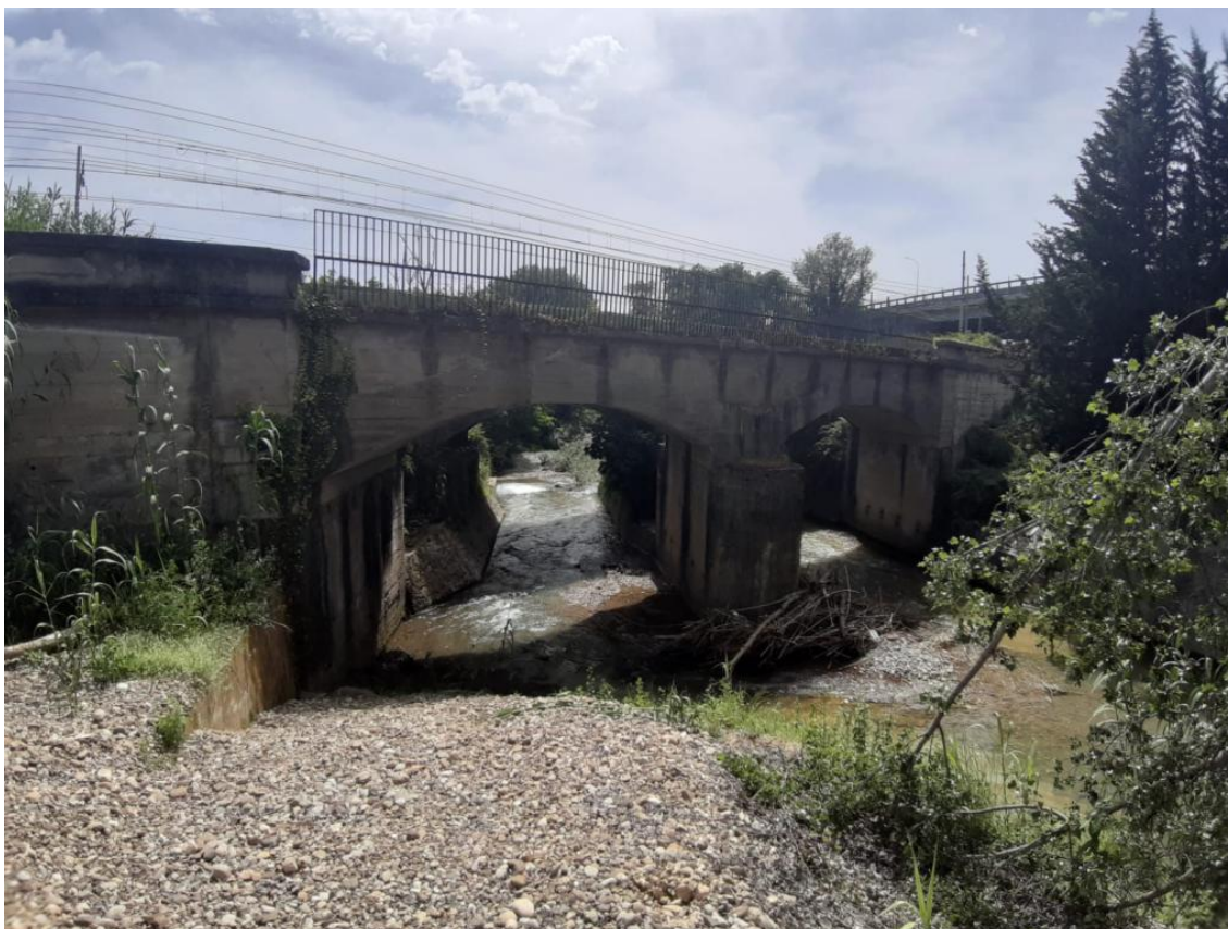
Figura 3-1 Ponte ferroviario in disuso sul Fiume Picentino al km 62+085 LS
