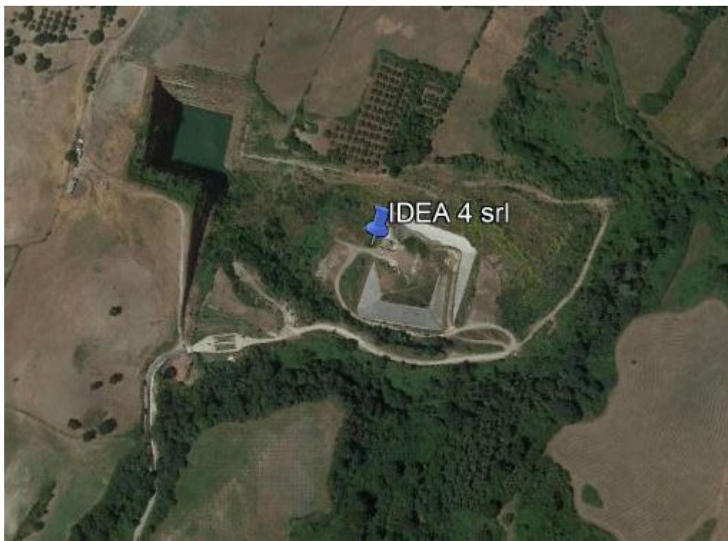
Figura 5-5 Idea 4 Srl – ubicazione impianto
