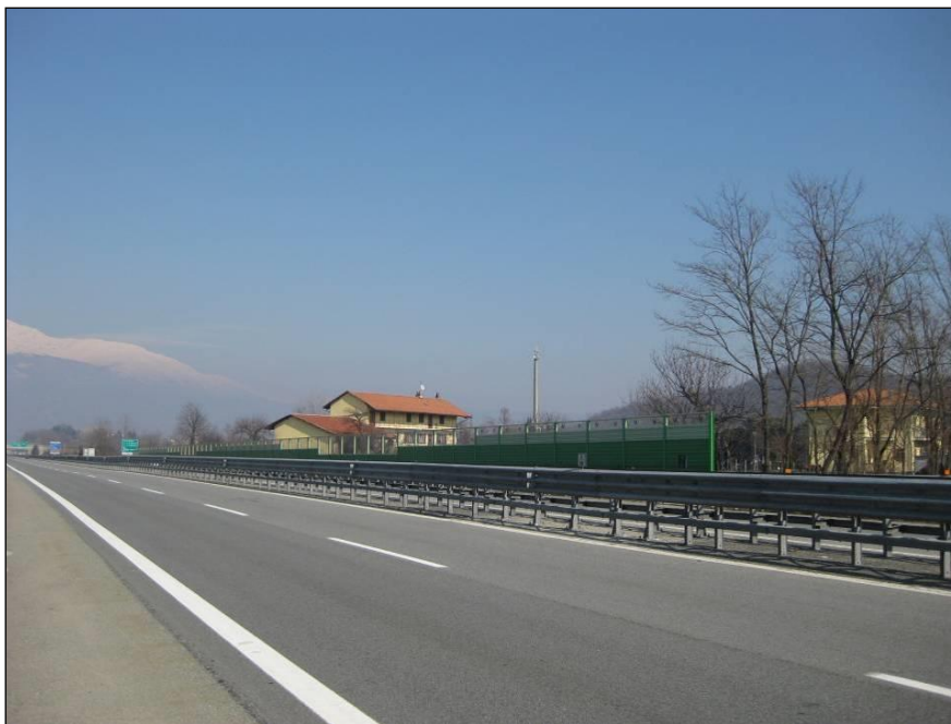
Figura 5.3.1/5 Macroarea di Pavone, area critica 1 – Barriera antirumore realizzata
