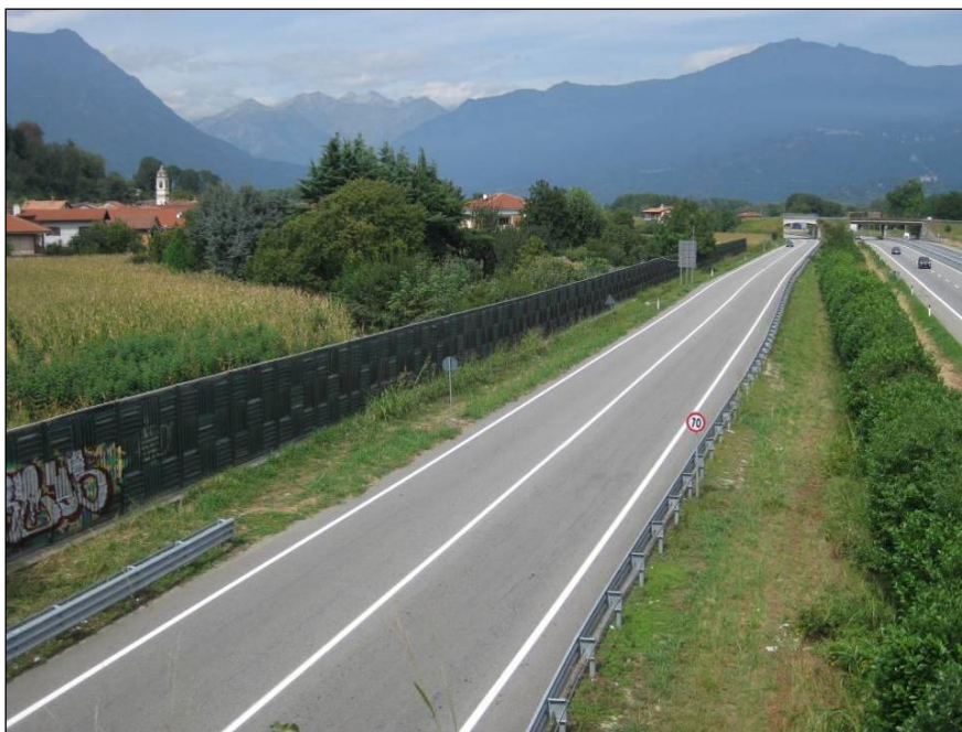
Figura 5.3.1/6 Macroarea di Saleranno, area critica 3 – Barriera antirumore realizzata lungo la Strada provinciale che affianca l'autostrada. Sono presenti due tratti di barriera antirumore, uno a copertura dei ricettori S8 ed S9, come di seguito identificati, ed uno, più breve, in prossimità del sovrappasso nello sfondo della foto, a copertura del ricettore S10
