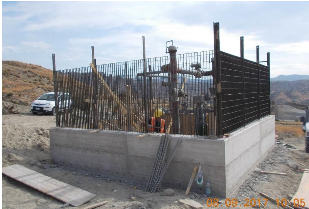
Figura 2.3/J: Costruzione di un punto di intercettazione (P.I.D.I./P.I.L./P.I.D.S./P.I.D.A.)
