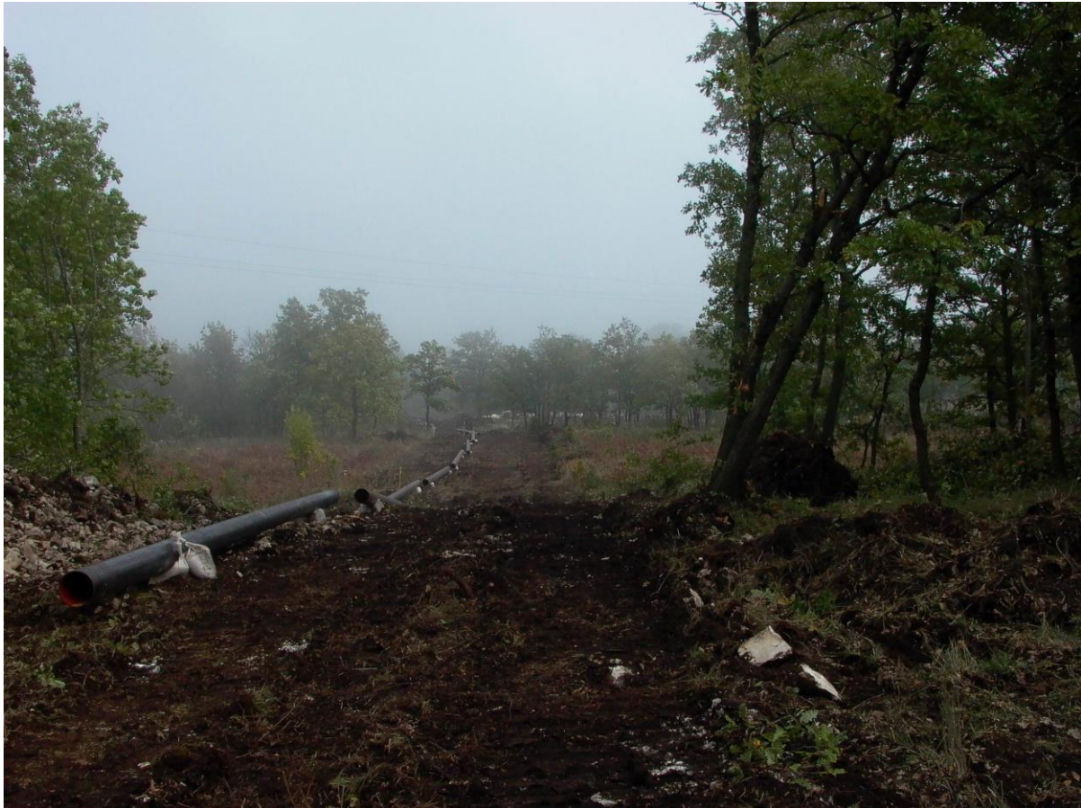
Figura 2.3/B: Esempio di sfilamento delle tubazioni
