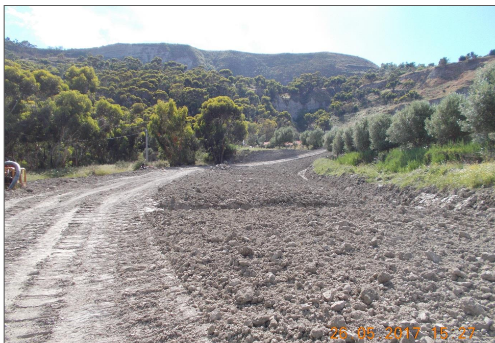
Figura 2.3/F: Esempio di rinterro della condotta (1)
