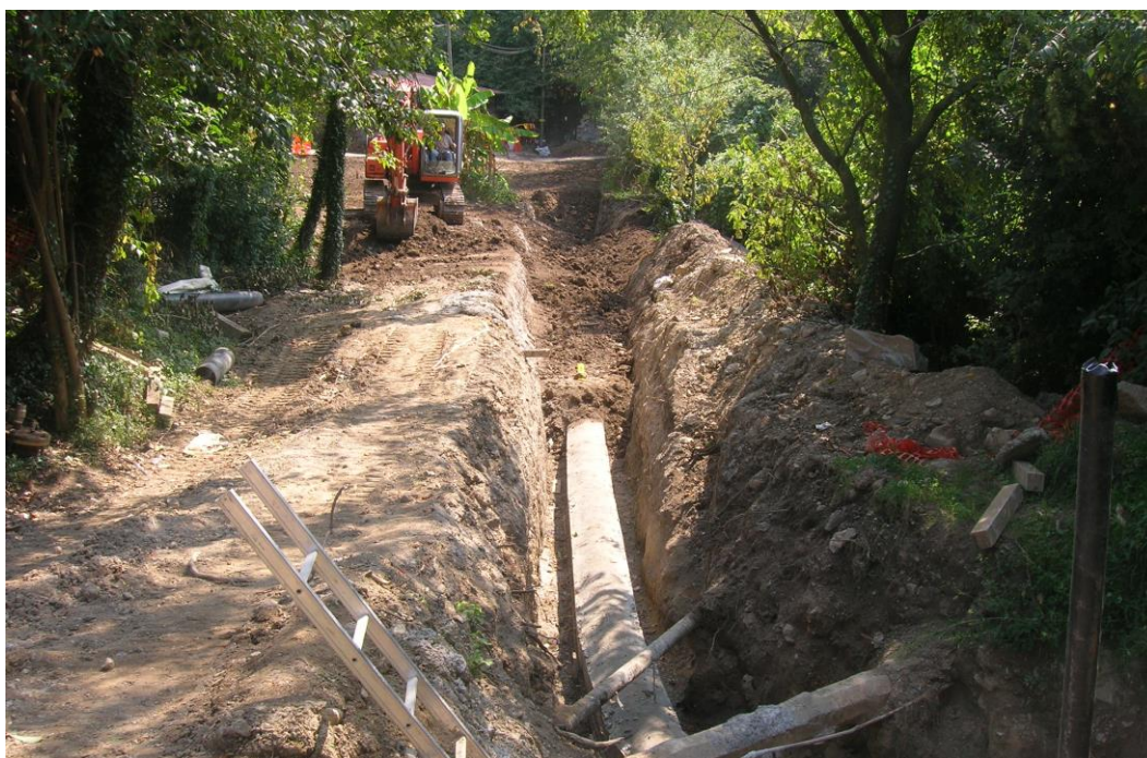
Figura 2.3/F: Esempio di rinterro della condotta (1)
