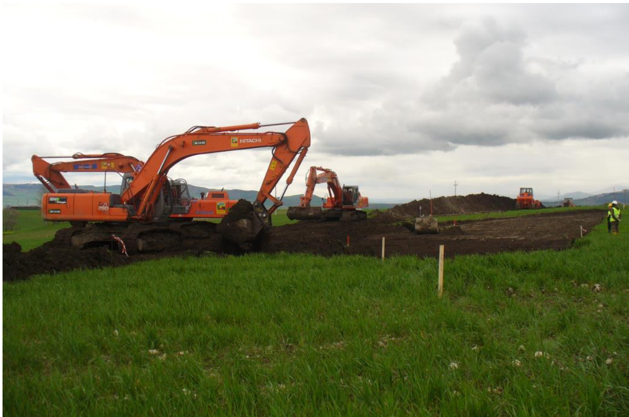
Figura 2.3/A: Esempio di apertura area di passaggio
