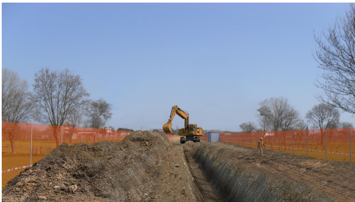
Figura 2.3/D: Esempio di scavo della trincea
