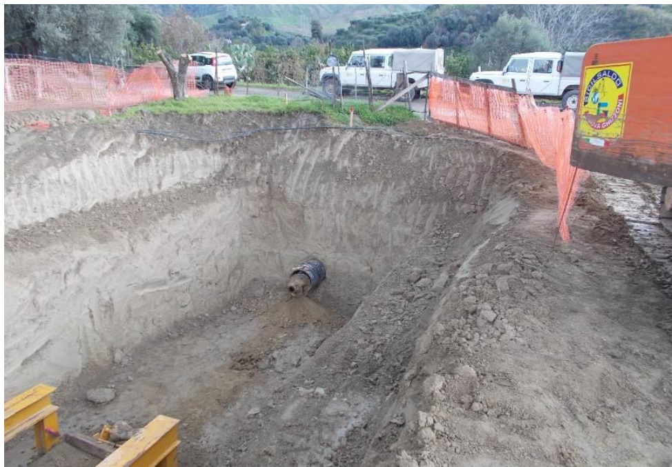
Figura 2.3/H: Trivellazione con spingitubo
