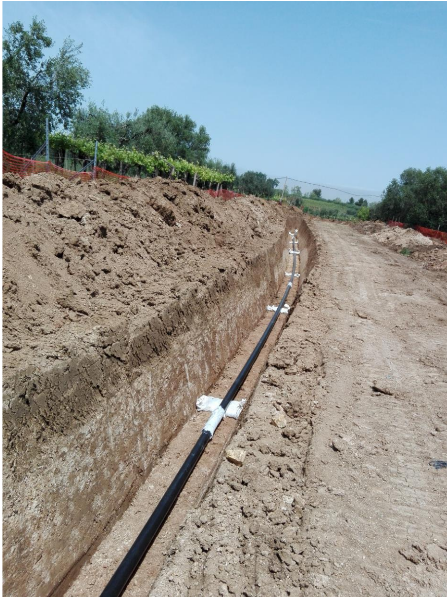
Figura 2.3/E: Esempio di posa della condotta
