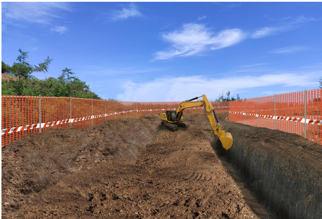
Figura 3.2/Q: Fase di scavo della trincea
