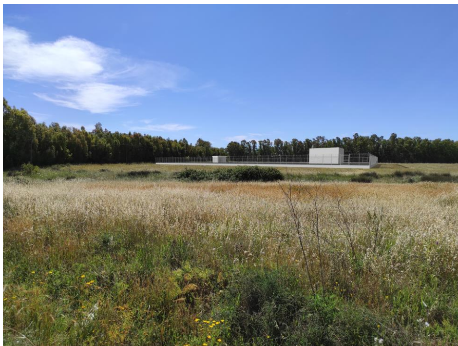
Figura 3.2/KK: Impianto PIDI1 – TRAPP DN 650 senza mitigazione
