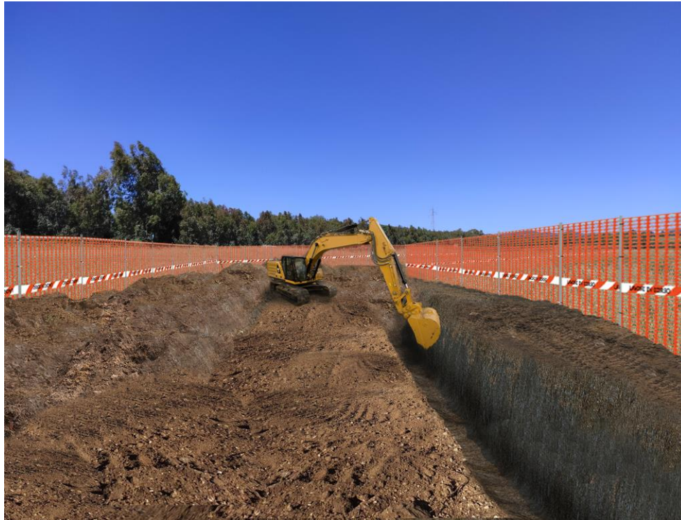
Figura 3.2/III: Fase di scavo della trincea
