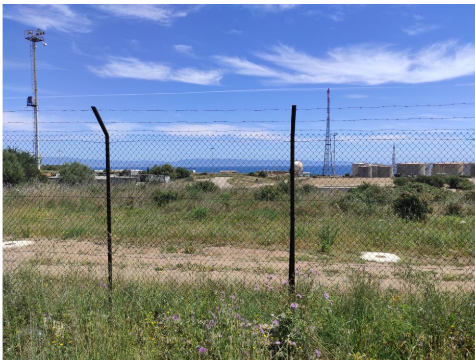
Figura 3.1/F: Area industriale – Lato mare
