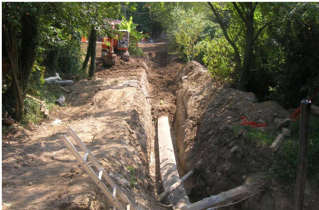
Figura 7.1/F: Esempio di rinterro della condotta (1)
