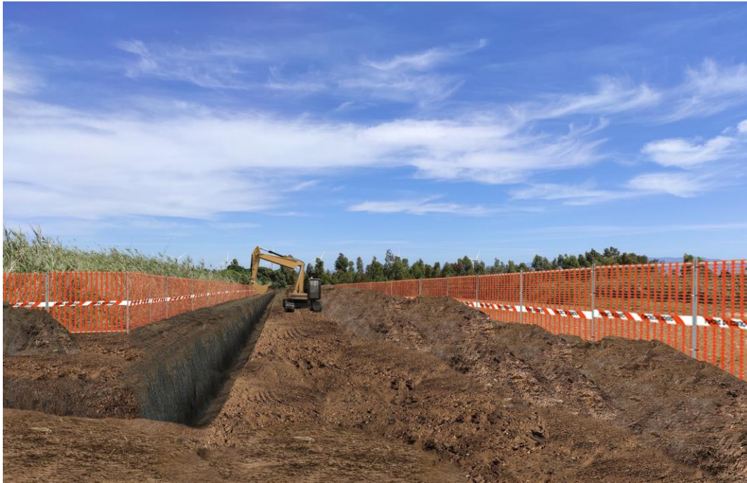
Figura 3.2/BB: Fase di scavo della trincea
