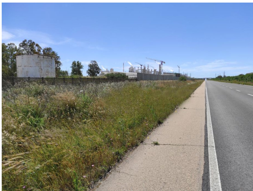
Figura 3.2/NN: Vista allo stato attuale
