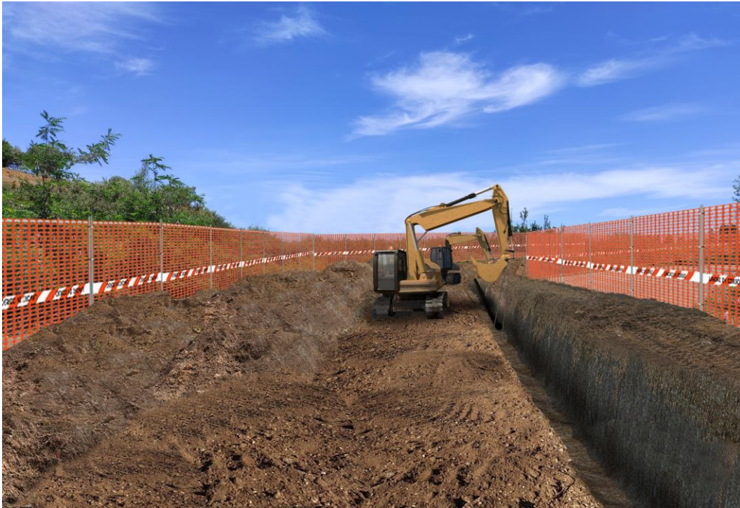
Figura 3.2/R: Fase di posa delle tubazioni
