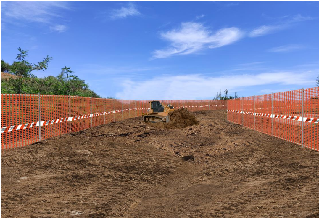
Figura 3.2/P: Fase di apertura della pista
