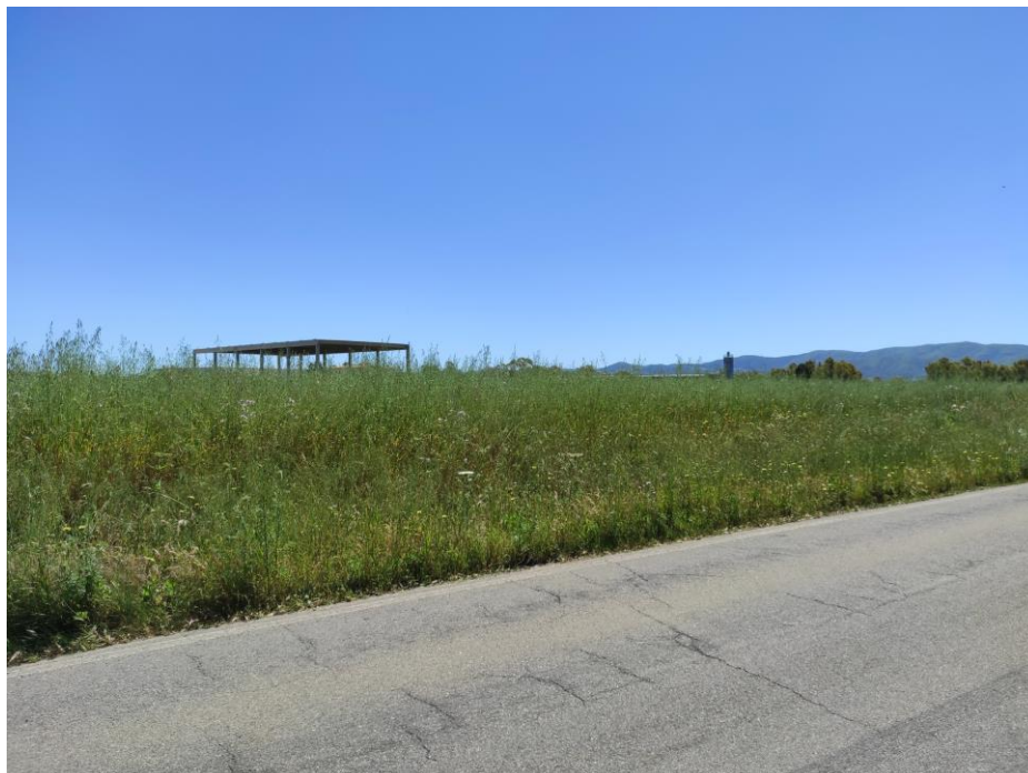
Figura 3.2/CCC: Vista allo stato attuale
