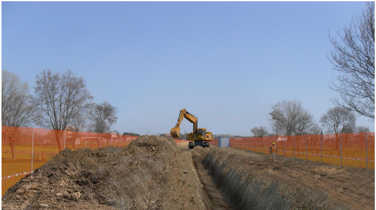
Figura 7.1/D: Esempio di scavo in trincea
