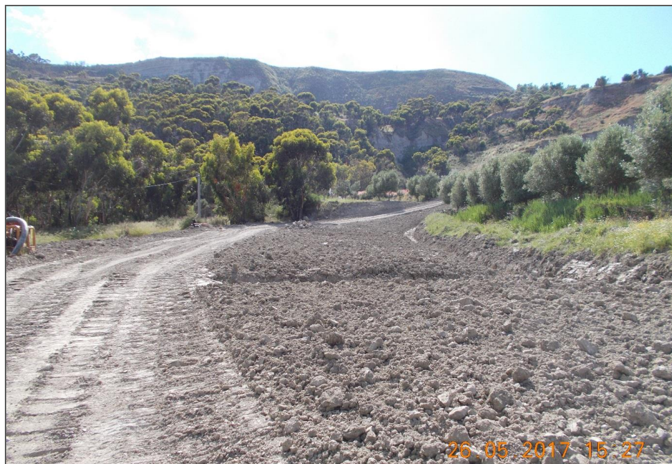
Figura 7.1/G: Esempio di rinterro della condotta (2)
