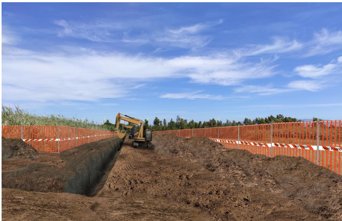
Figura 3.2/CC: Fase di posa delle tubazioni
