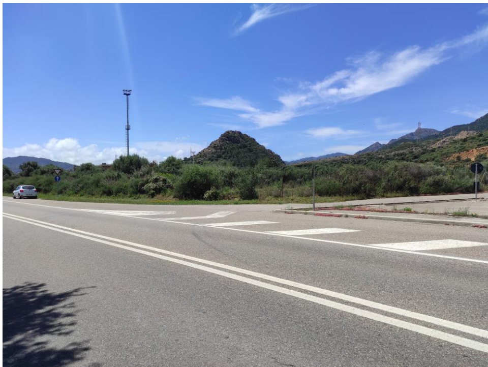
Figura 3.2/G: Vista allo stato attuale
