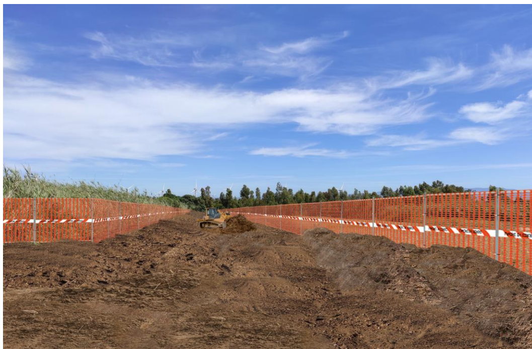
Figura 3.2/AA: Fase di apertura della pista
