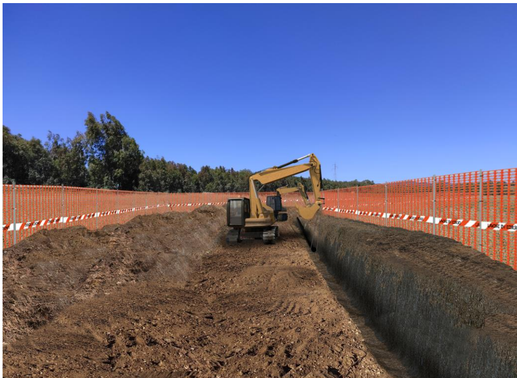
Figura 3.2/JJJ: Fase di posa delle tubazioni
