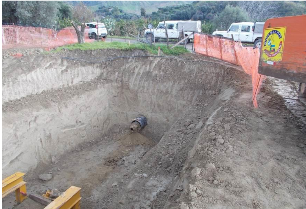
Figura 7.1/H: Trivellazione con spingitubo
