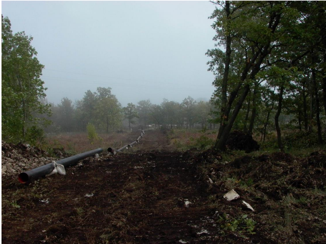
Figura 7.1/B: Esempio di sfilamento delle tubazioni
