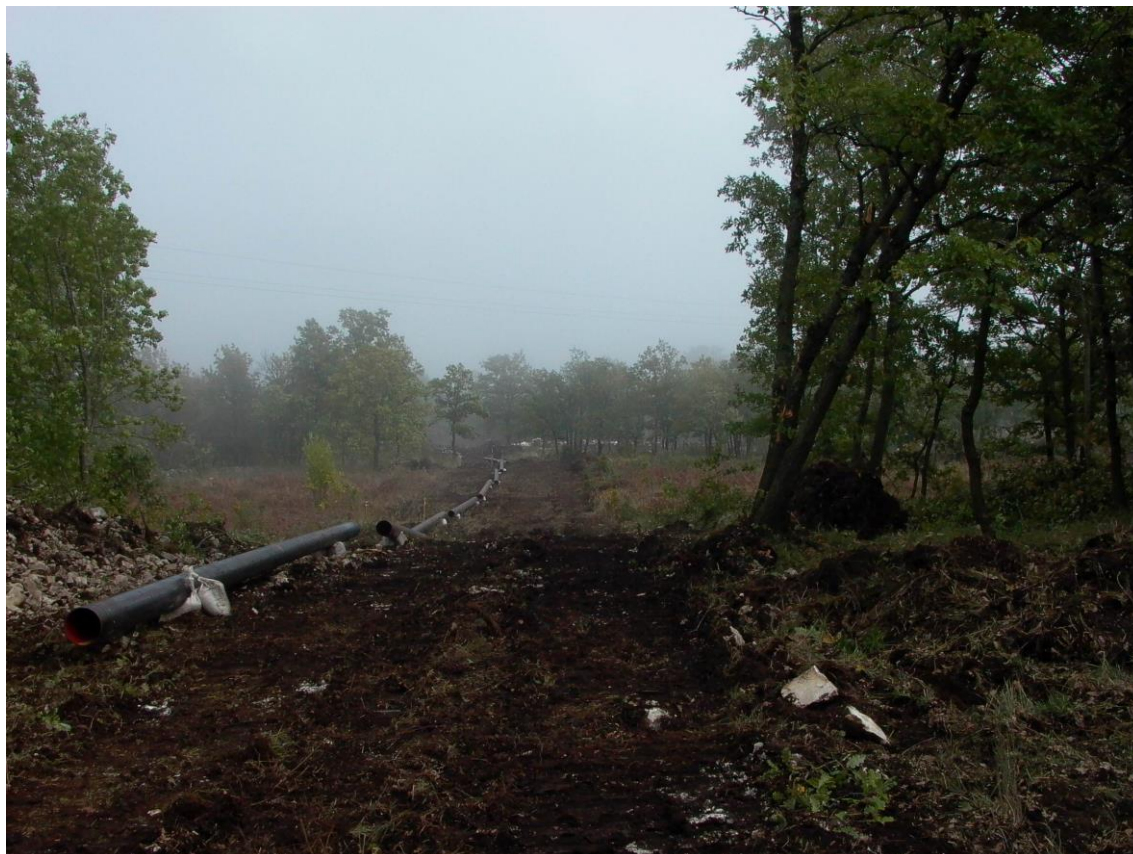
Fig. 3.2/C: Esempio di sfilamento delle tubazioni
