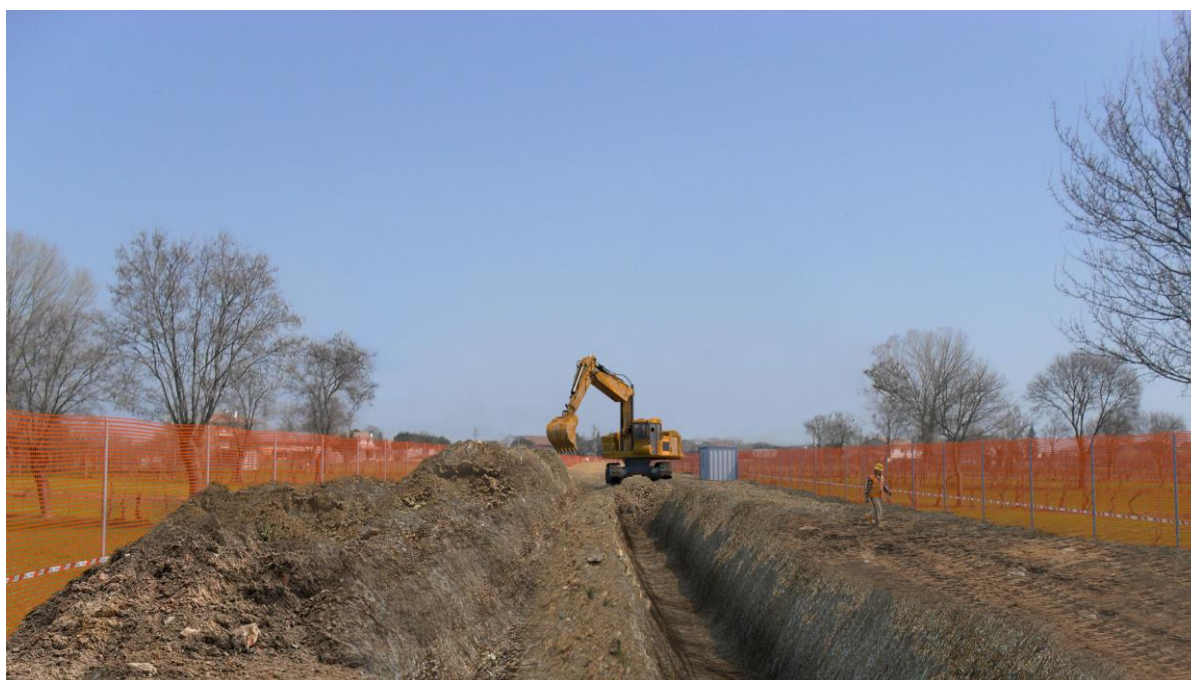
Fig. 3.2/D: Esempio di scavo della trincea
