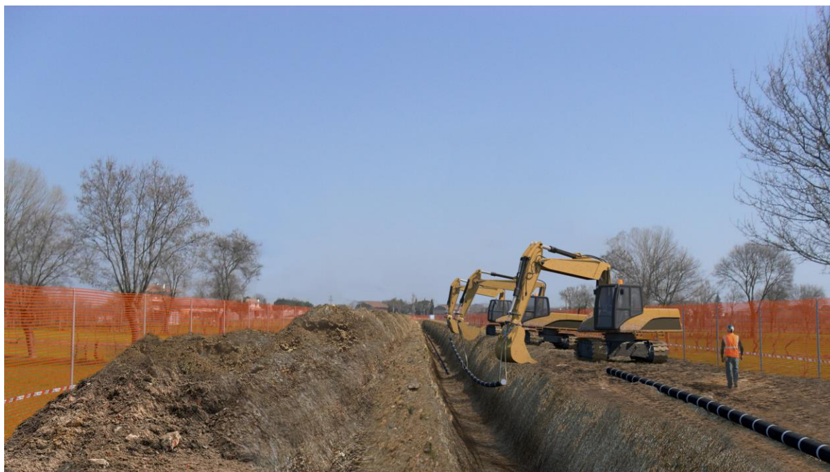
Fig. 3.2/E: Esempio di Posa della condotta
