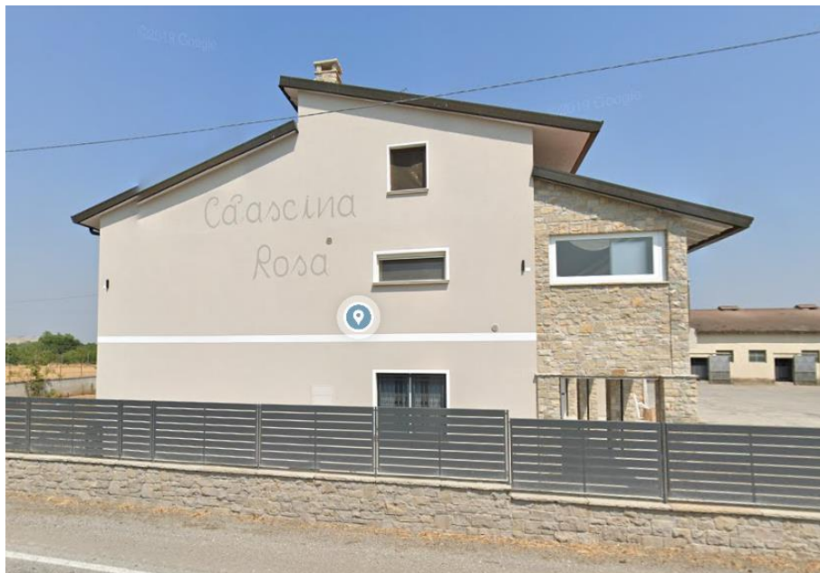
Figura 3-11 Ricettore R092, facciata esposta al rumore stradale lungo la SP37 e numero e tipologia infissi interessati
