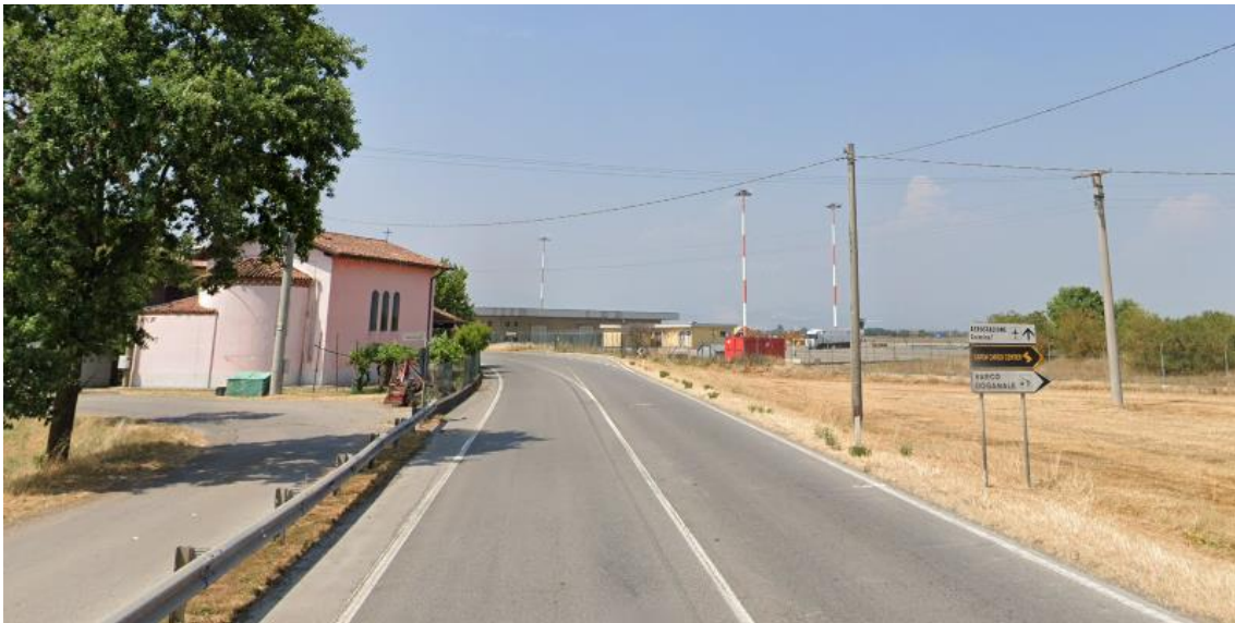
Figura 3-2 Tratto della SP37 in prossimità dell'Aeroporto di Brescia-Montichiari
