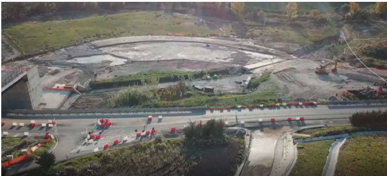
Figura 5 - Foto da drone dell'area in esame a seguito dell'evento alluvionale di Novembre 2018
