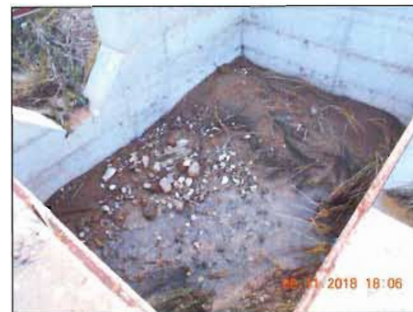
Foto 4 – TP28 (Pozzetto di monte)
