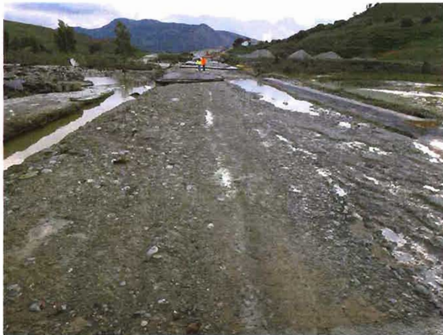
02/11/2018 – AP18 prima del Viadotto San Leonardo (direzione PA)
