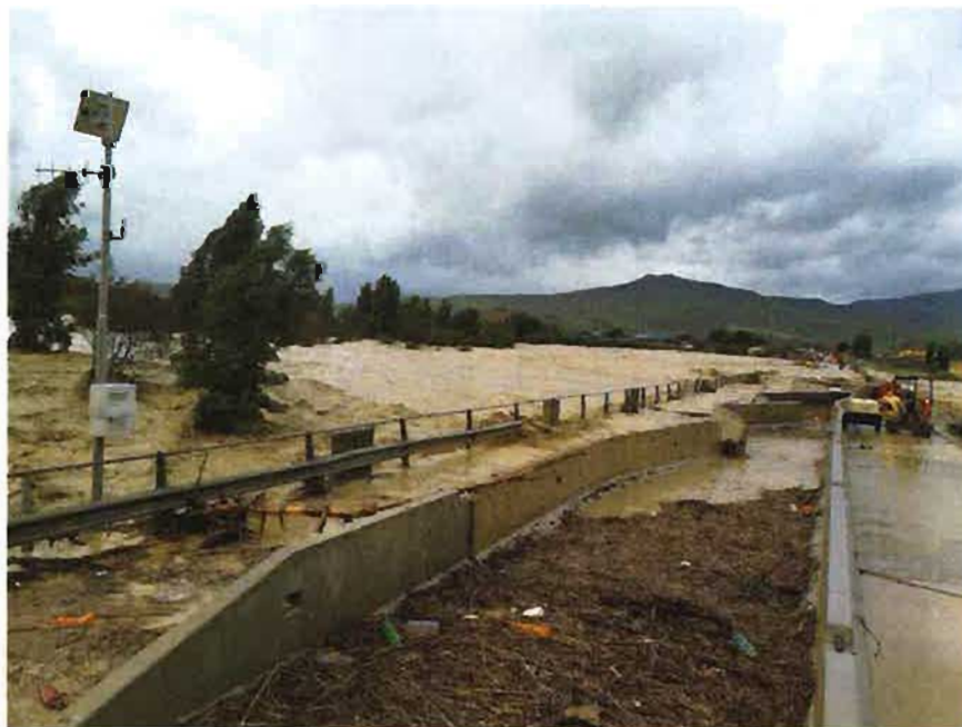
02/11/2018 - Viadotto San Leonardo (direzione PA)
