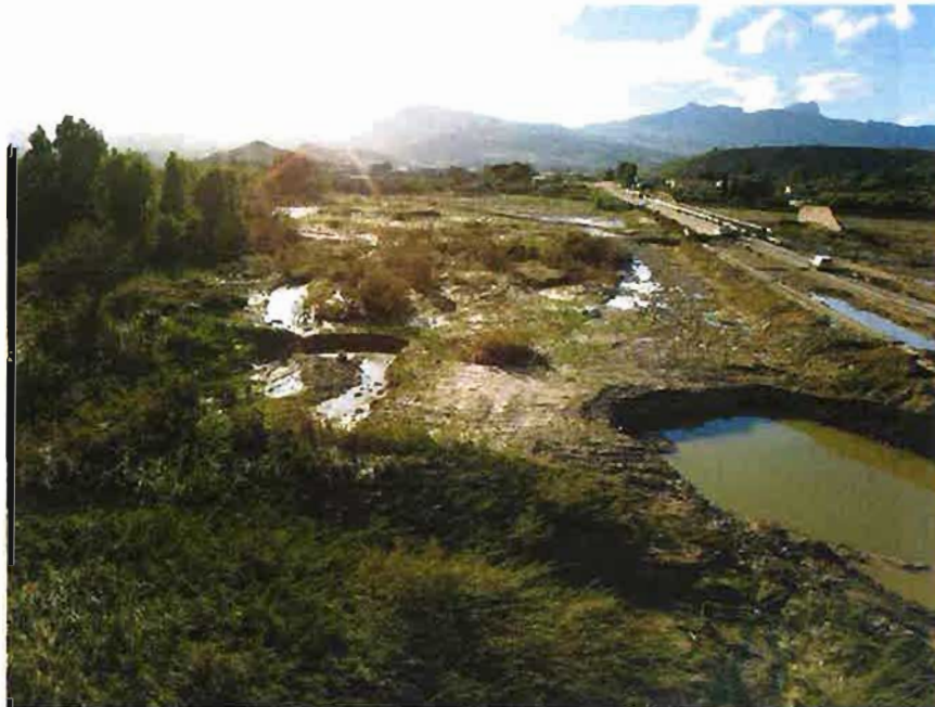
05/11/2018 – Zona AP18/Viadotto Esistente San Leonardo
