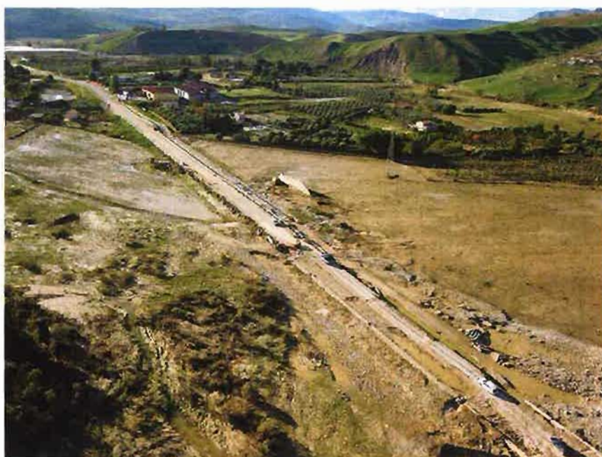
05/11/2018 – Zona AP18/Viadotto Esistente San Leonardo
