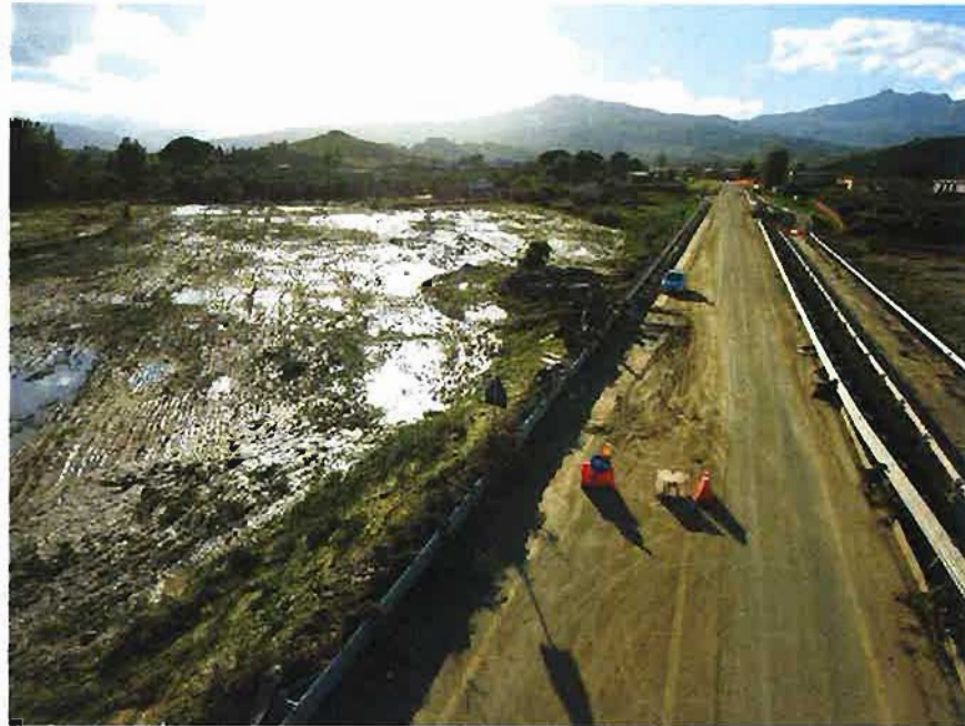
05/11/2018 – Zona AP18/Viadotto Esistente San Leonardo
