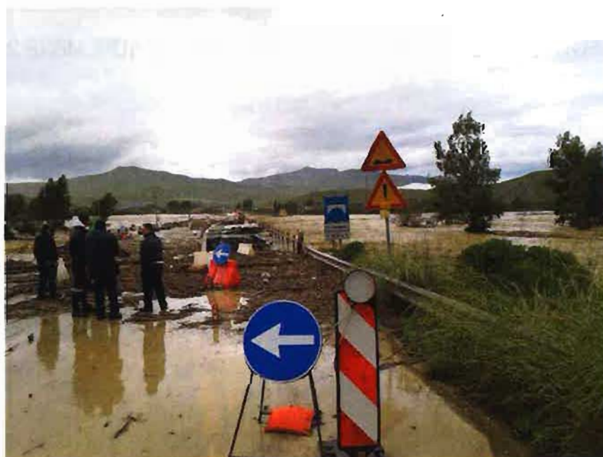
02/11/2018 - Viadotto San Leonardo (direzione PA)
