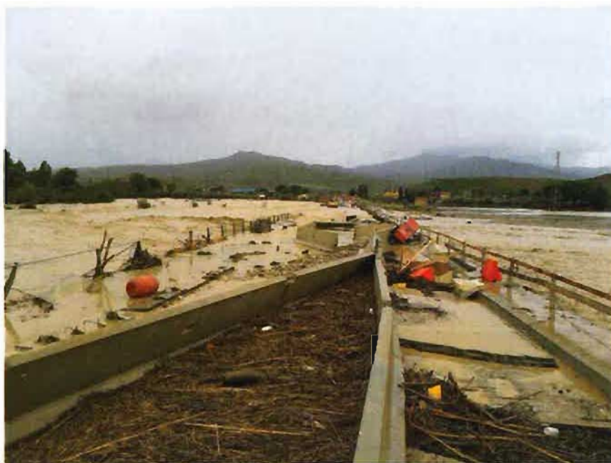
02/11/2018 - Viadotto San Leonardo (direzione PA)
