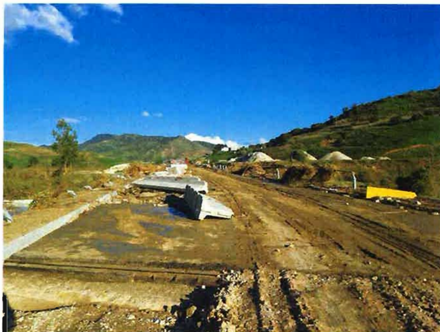
04/11/2018 – Zona AP18/Viadotto Esistente San Leonardo
