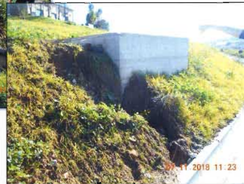
Foto 6 – SV06 (TP49 – Pozzetto di monte)
