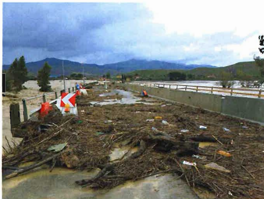
02/11/2018 - Viadotto San Leonardo (direzione PA)
