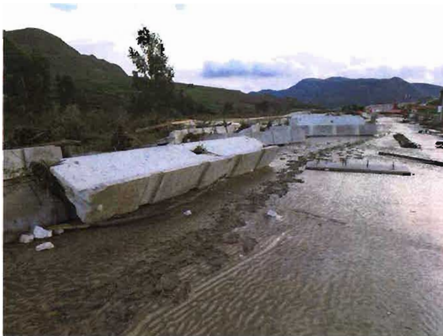
03/11/2018 - Viadotto San Leonardo (direzione AG)
