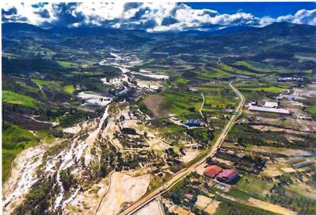
04/11/2018 – Zona AP18/Viadotto Esistente San Leonardo
