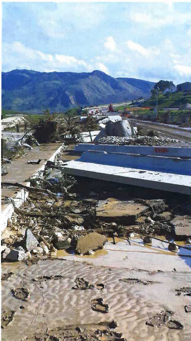
03/11/2018 - Viadotto San Leonardo (direzione AG)
