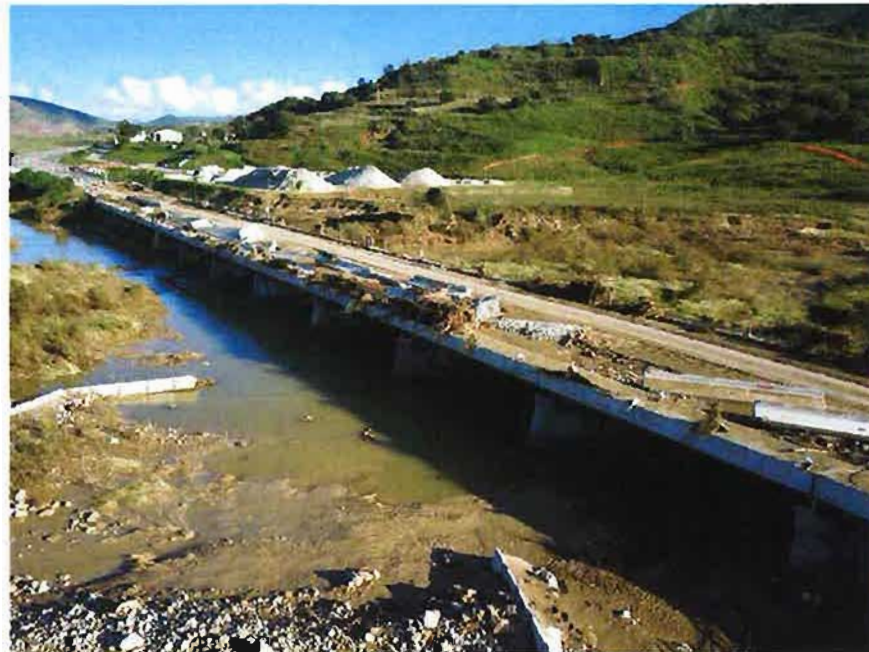
05/11/2018 –Viadotto Esistente San Leonardo
