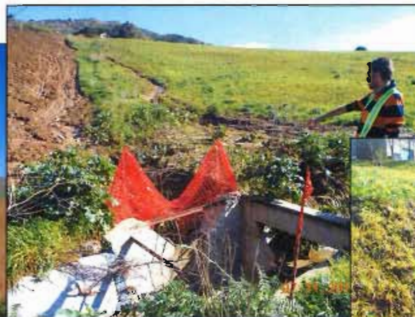
Foto 5 – TS29 (Pozzetto di monte)
