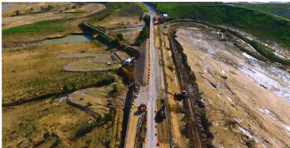
16/11/2018 – Foto aerea Ponte ad ARCO VE04 zona esondazione torrente Azzirolo
