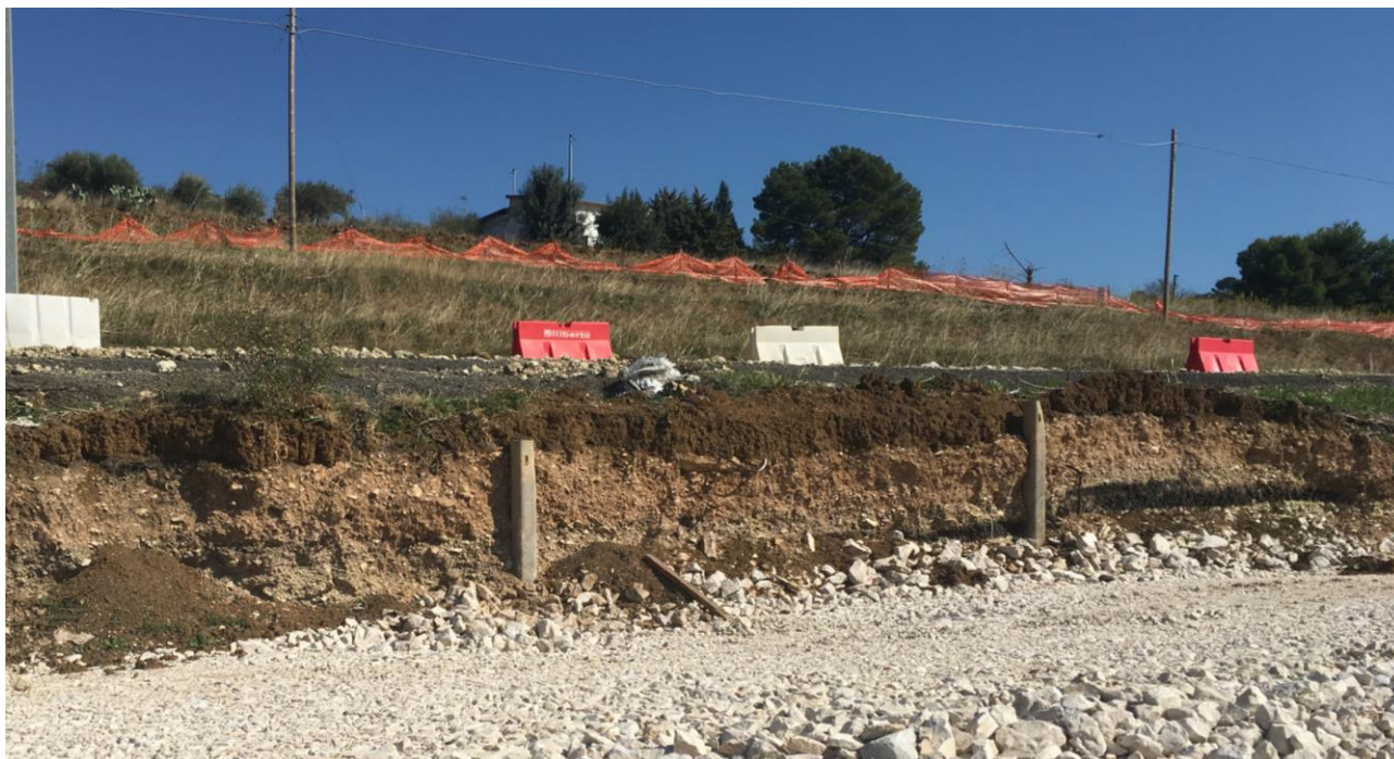
Fig. 3. Sezione stradale n.282 - sostegni delle vecchie barriere stradali e vecchia pavimentazione ricoperti da successive ricariche di materiale da rilevato.
