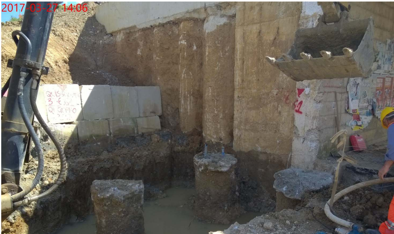
Figura 5 – Muro di risvolto esistente solidale al sottovia ST05.
