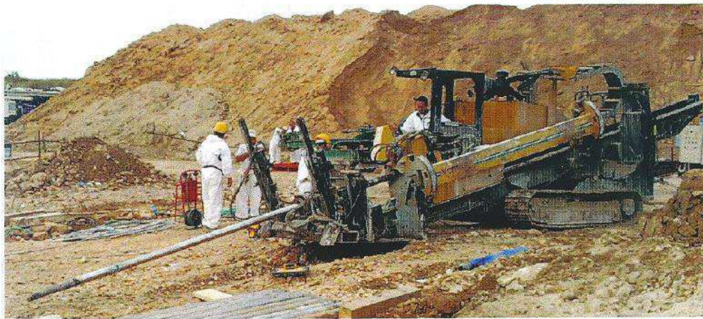
Figura 31 Esempi di macchine perforatrici in lavorazione
