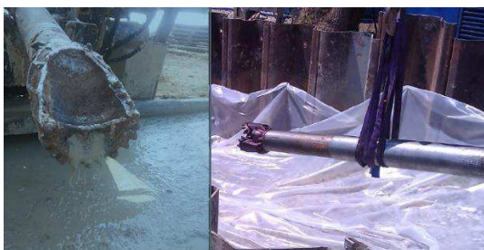
Figura 32 Esempi di teste di perforazione
