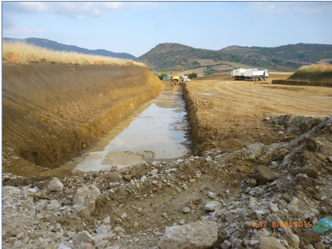
Figura 3 – Sezione di scavo muro di sostegno OS99.
