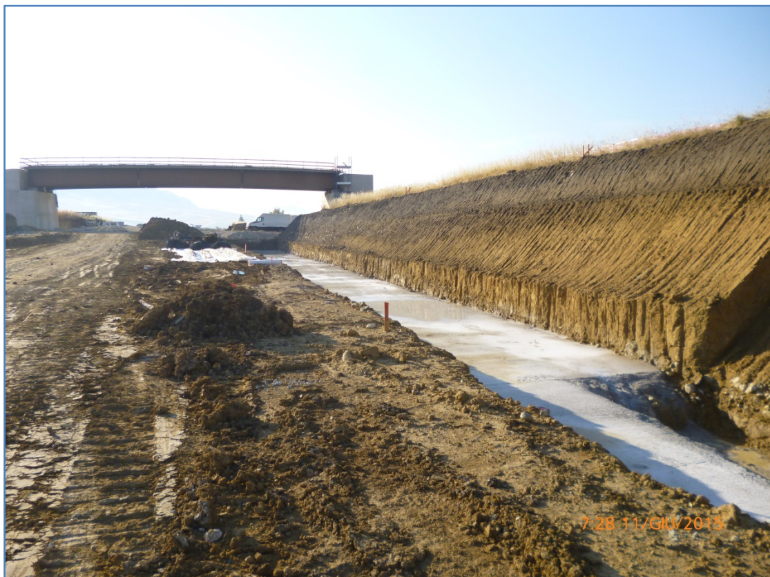
Figura 4 – Sezione di scavo muro di sostegno OS99.
