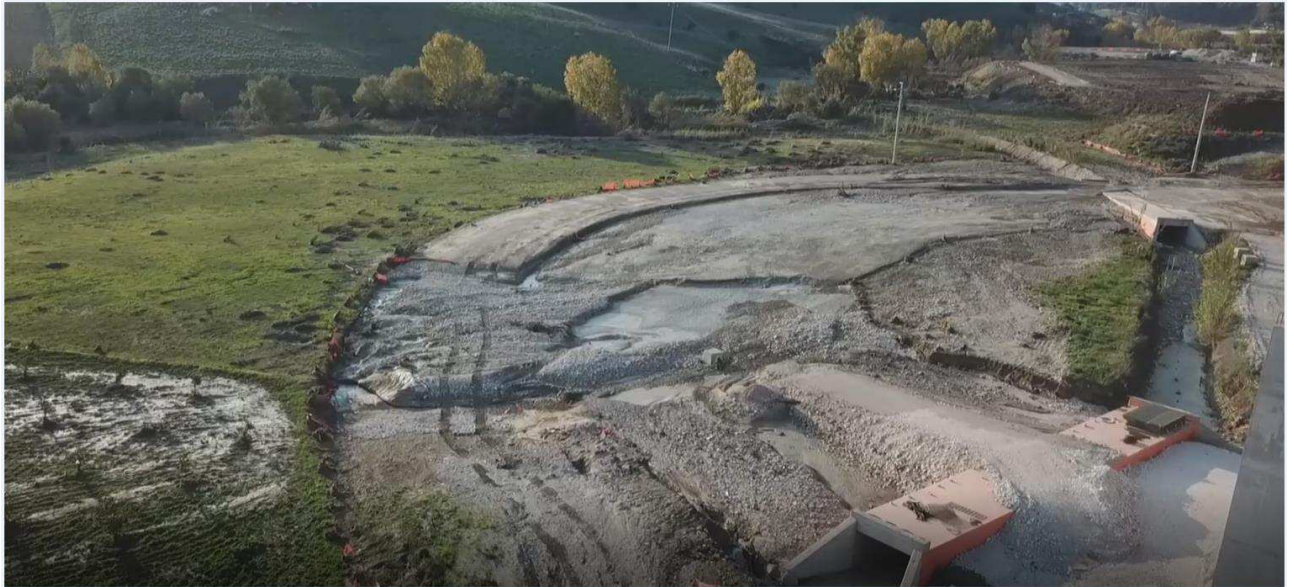
Figura 2 Foto da drone dell'area in esame a seguito dell'evento alluvionale di Novembre 2018
