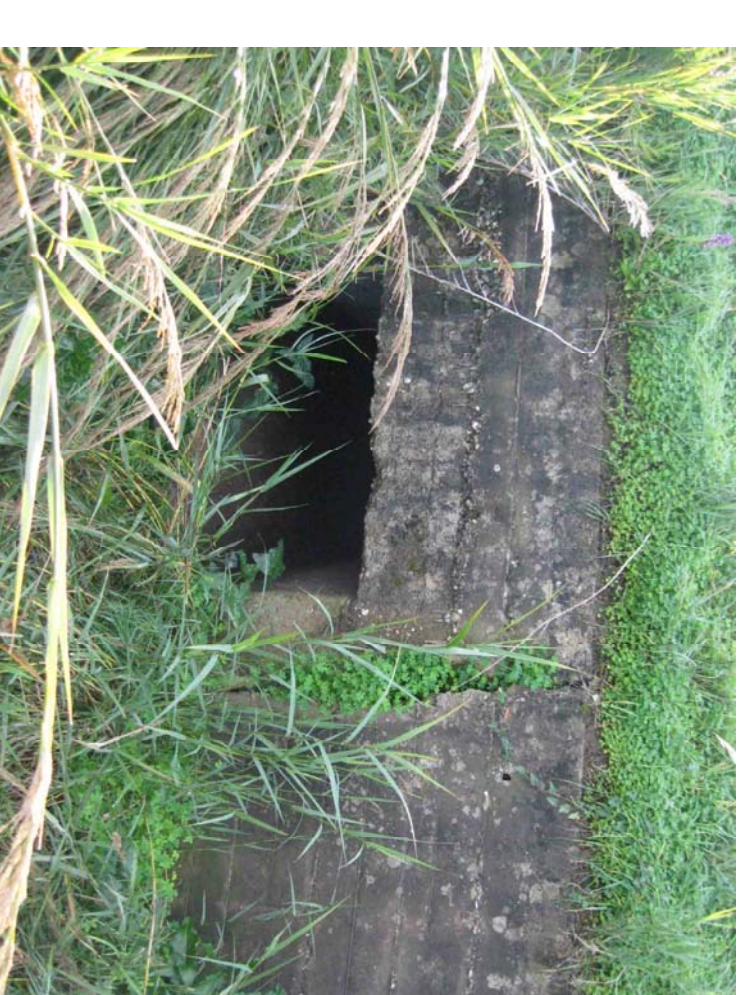
Manufatto di sbocco
