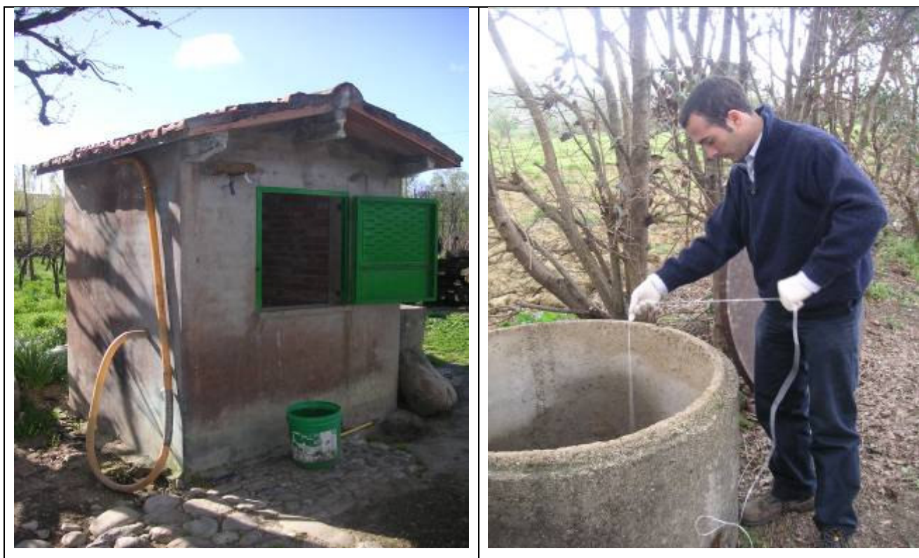
Figura 3.5-8: Punti di prelievo con campionamento mediante boiler monouso - corrispondenti ai punti GW 1 e GW3 in Tavola 3.3)
