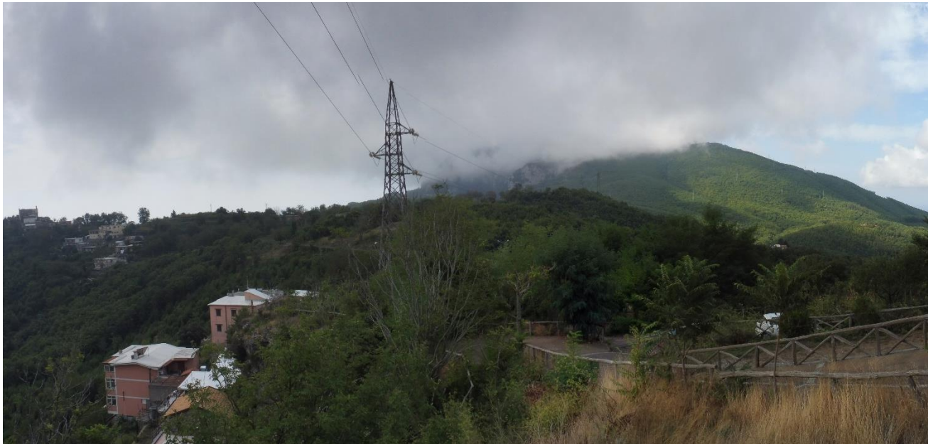
Figura 44 – PDV 5 – Stato di fatto
