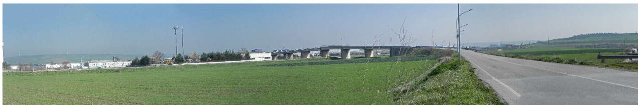
Figura 8: panoramica dell’area di intervento ripresa dalla SP124
