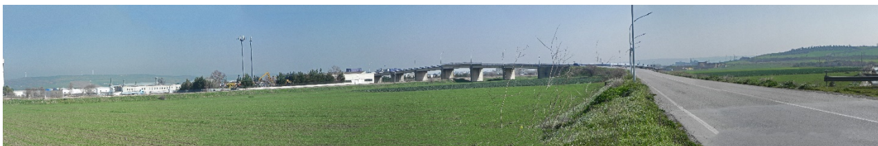
Figura 25: Stato dei luoghi in corrispondenza del punto di ripresa fotografica C
