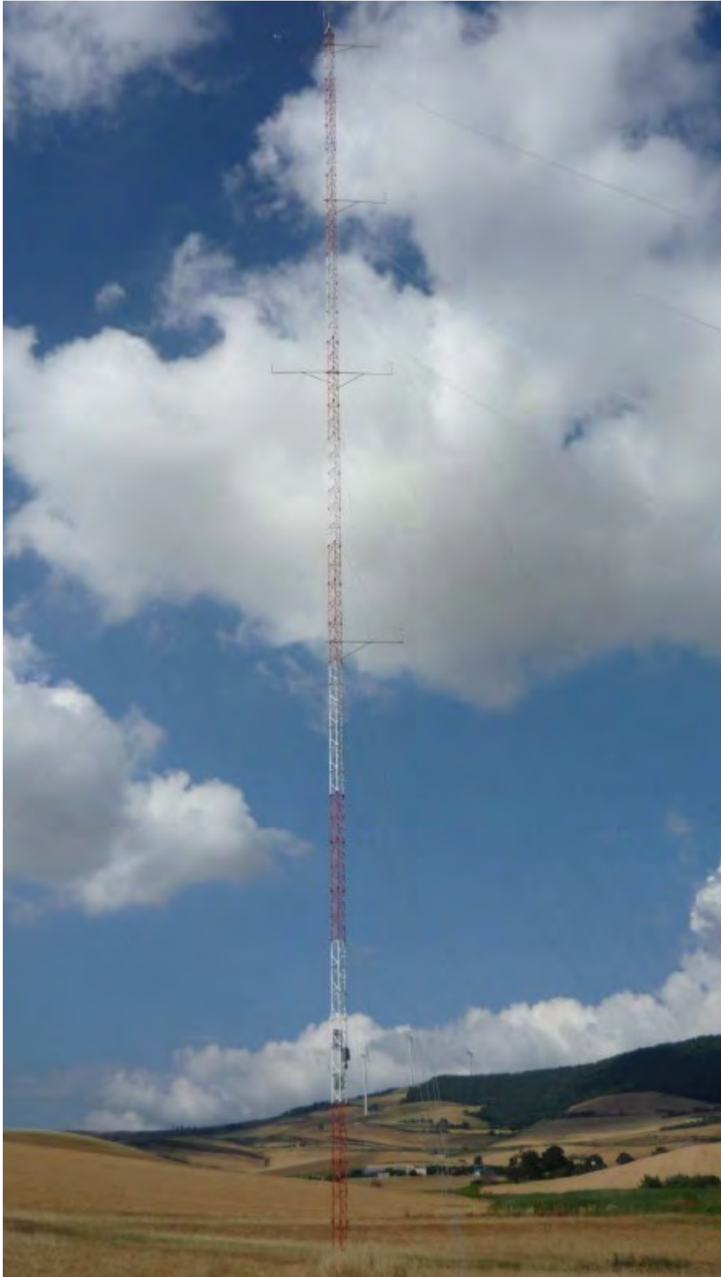
Figura 2.4: Torre anemometrica TP364
