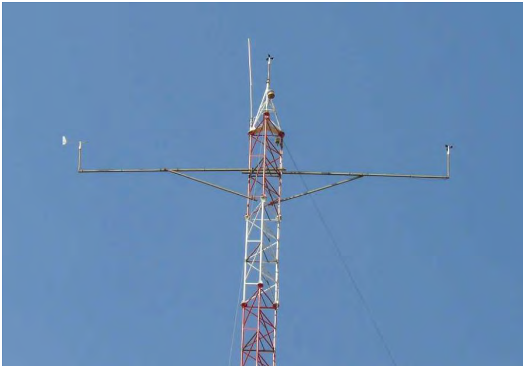
Figura 2.5: Torre anemometrica TP364, dettaglio dei livelli di misura a 99m e 102m
