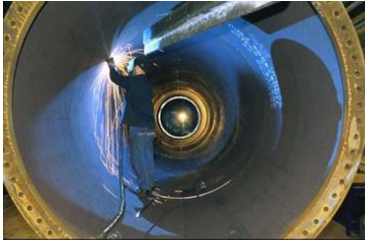
Figura 10: interno di una torre
