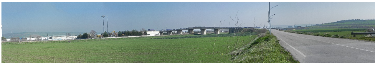
Figura 4: panoramica dell'area di intervento ripresa dalla SP124
