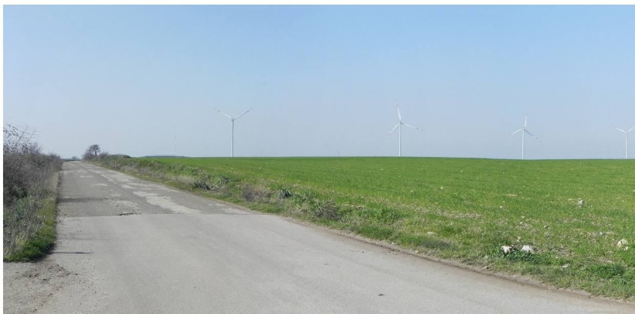
Figura 111: Stato dei luoghi in corrispondenza del punto di ripresa fotografica M (Venosa - tratturo Melfi-Castellaneta)
