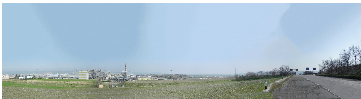
Figura 109: Stato dei luoghi in corrispondenza del punto di ripresa fotografica I (Melfi - SS655)
