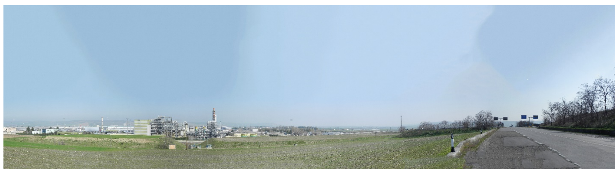
Figura 6: panoramica dell'area di intervento ripresa dalla SS655
