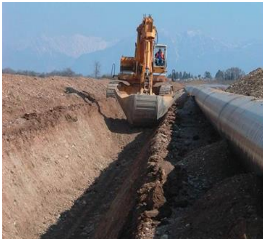
Fig. 5-3 - Scavo per l'alloggiamento della condotta
