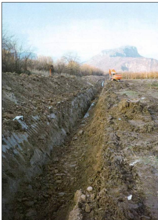
Fig. 5-5 - Operazione di rinterro della condotta
