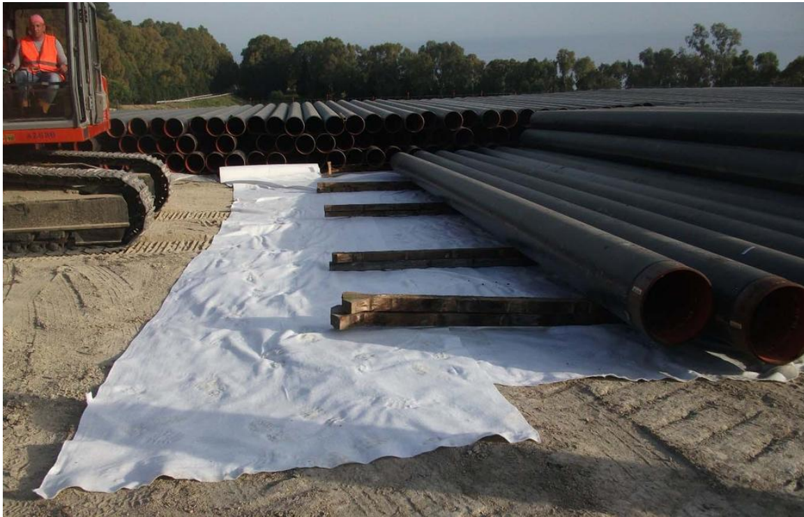
Fig. 5-1 - Piazzola di accatastamento tubazioni
