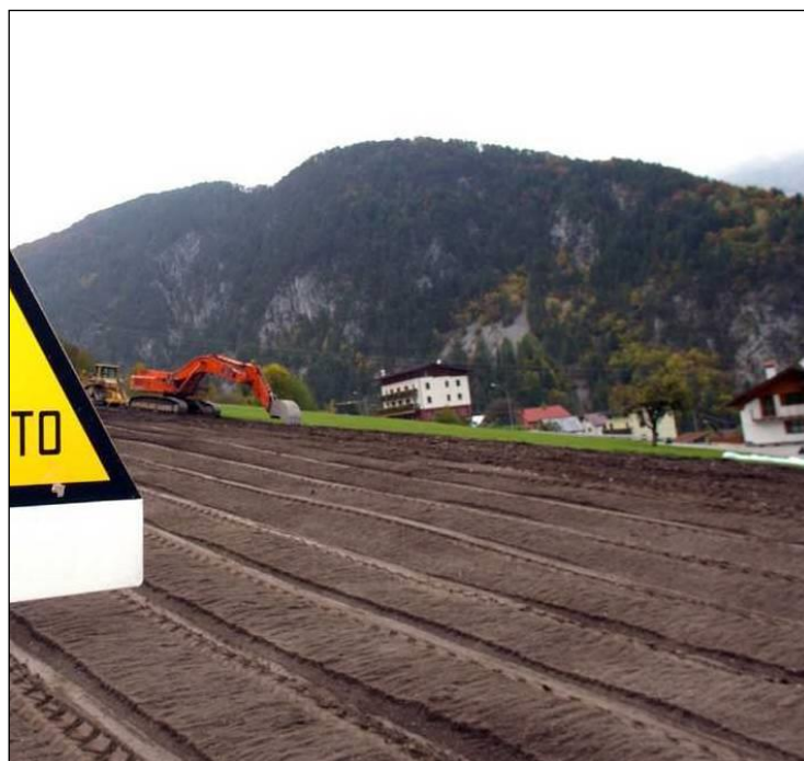
Fig. 5-6 - Ridistribuzione dello strato humico superficiale
