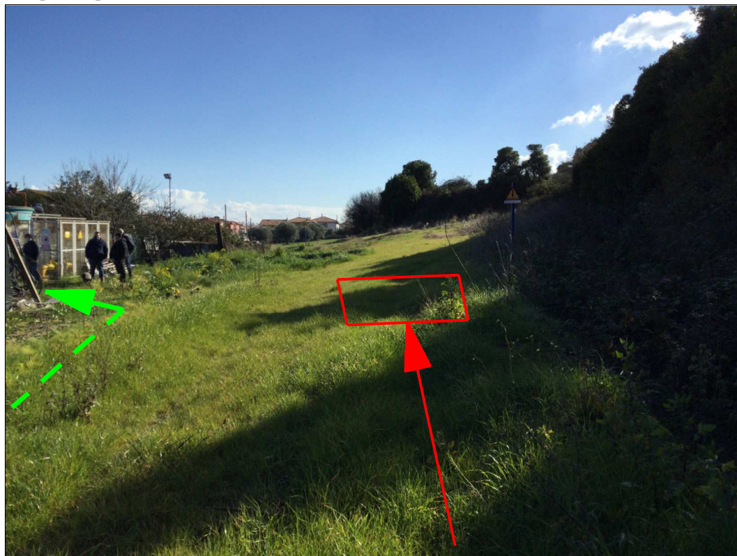
Ingresso metanodotto nel Nodo 6140
