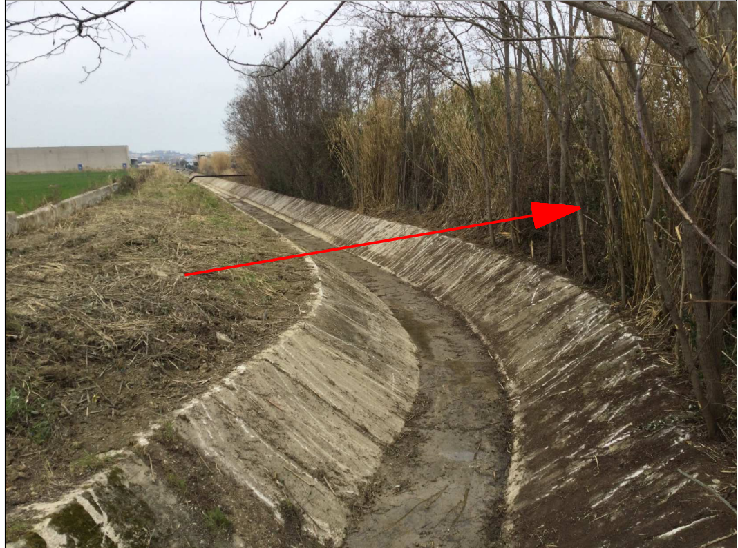
Attraversamento canale rivestito in c.a.
