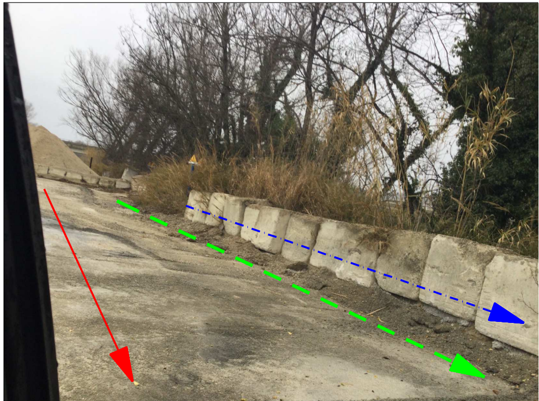
Percorrenza area azienda inerti / calcestruzzi
