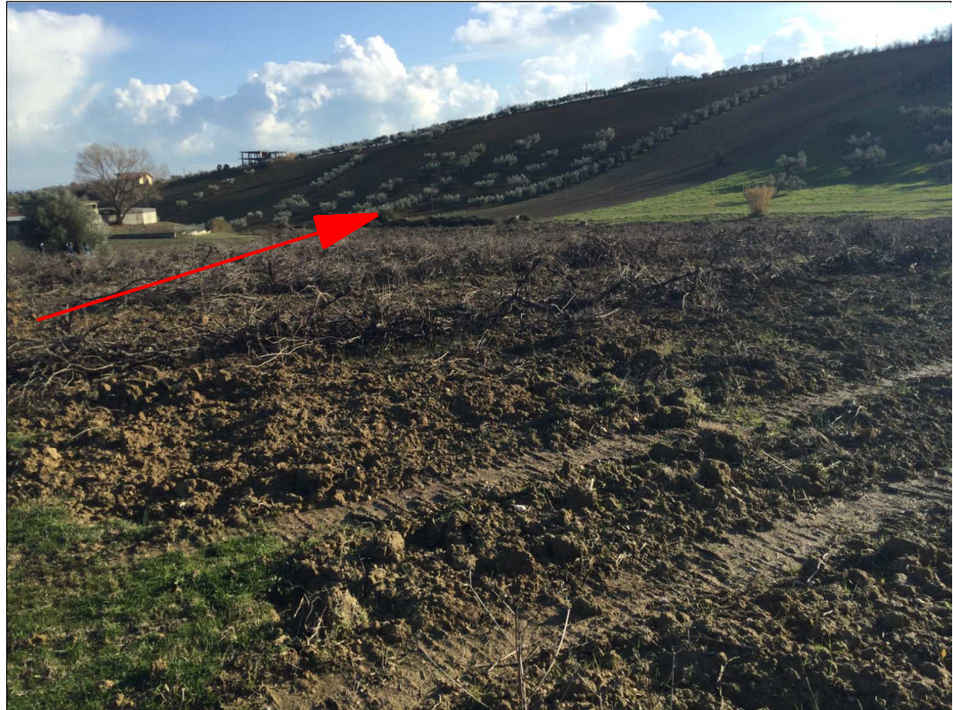
Punto di uscita Trenchless (TOC Colle Morino)
