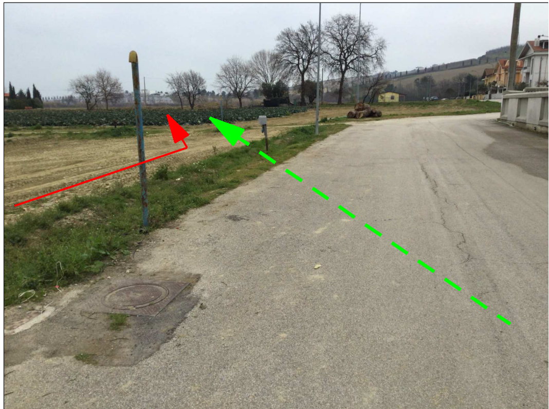
Attraversamento via Plutone
