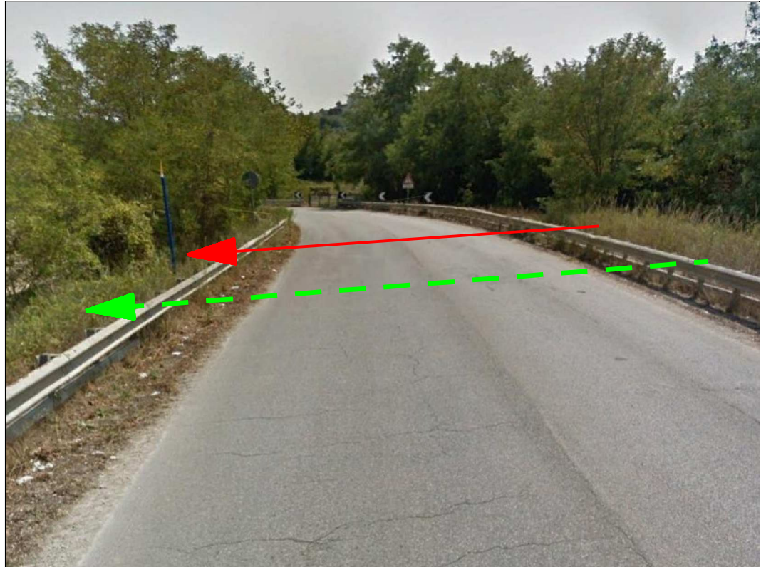
Attraversamento S.P. n.553
