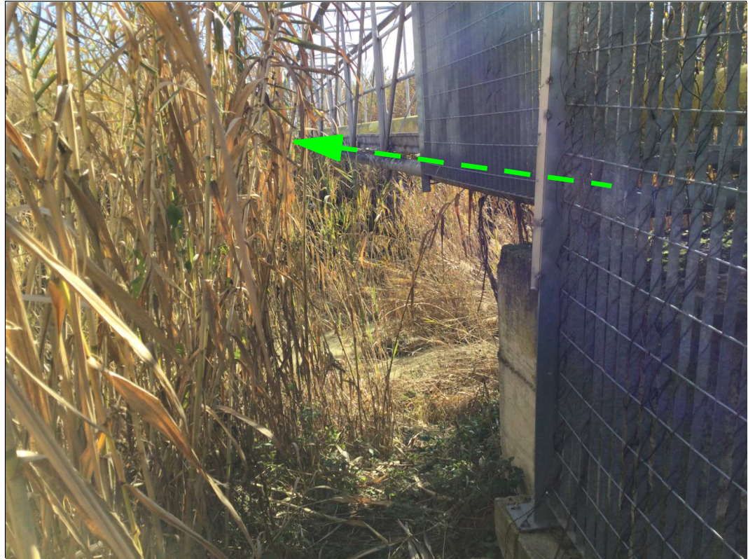
Attraversamento Fosso Calvano
