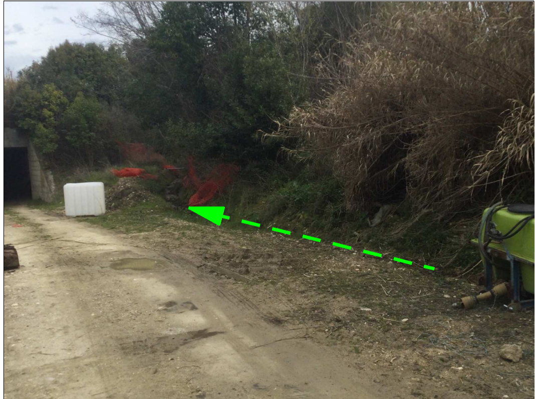
Attraversamento autostrada A14
