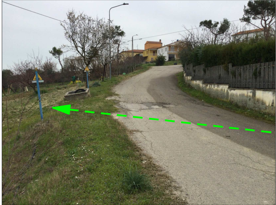
Attraversamento via degli Orti
