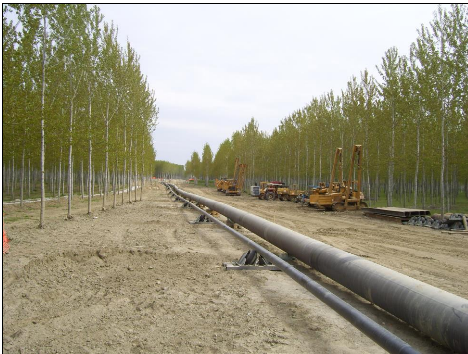
Attrav. F. Po con met. 30" – Colonna del pipeline preassemblata sulla pista di varo
