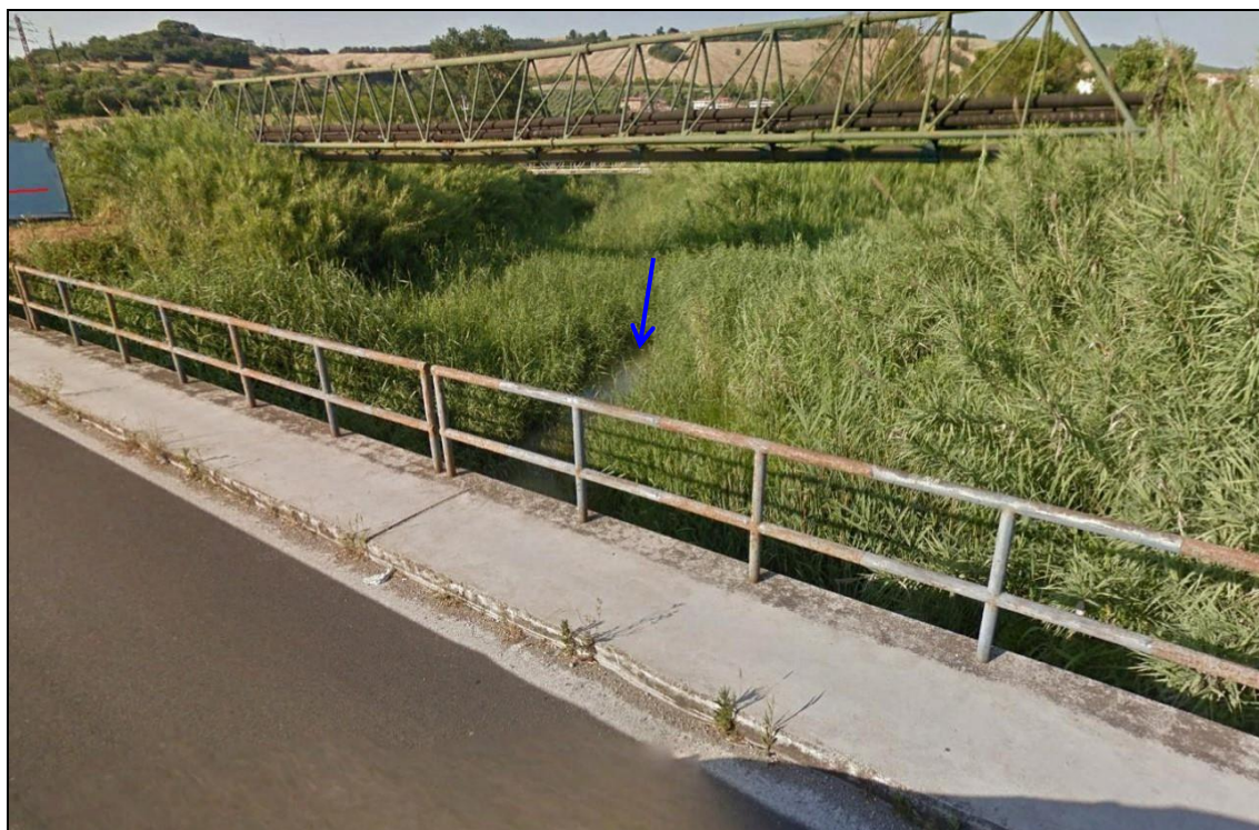
Fig.3.2/B: Foto del corso d'acqua (scattata dal ponte della S.S.16, verso monte)
