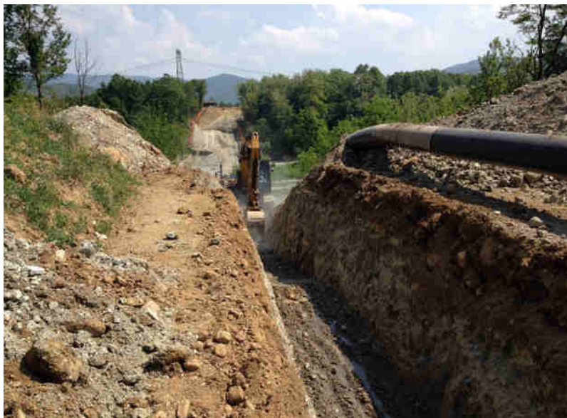
Fig. 2.2 - Scavo per l'alloggiamento della condotta.
