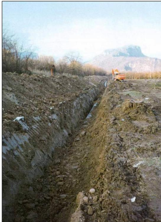
**Fig. 3.5 - Operazione di rinterro della condotta**
