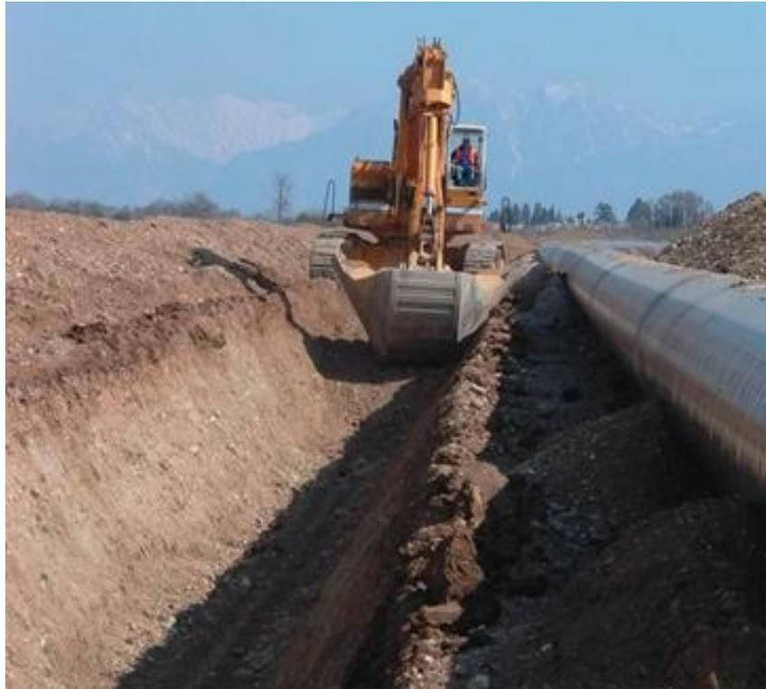
**Fig. 3.3 - Scavo per l'alloggiamento della condotta**
