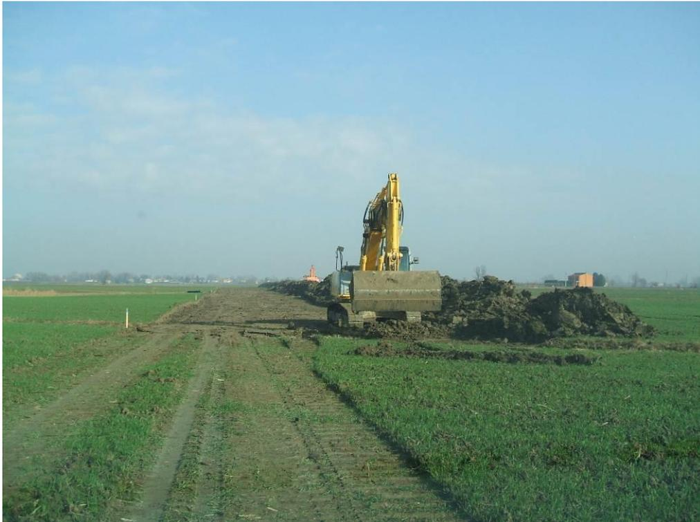
**Fig. 3.2- Apertura area di passaggio in area agricola**
