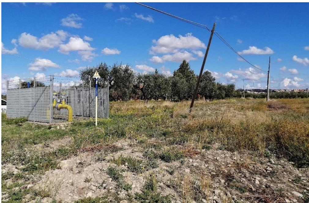
**Fig. 3.8 - Esempio di impianto di intercettazione di linea P.I.L.**
