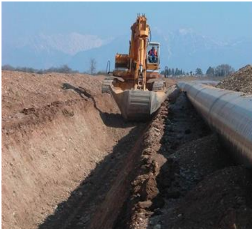
Fig. 7.3 - Scavo per l'alloggiamento della condotta
