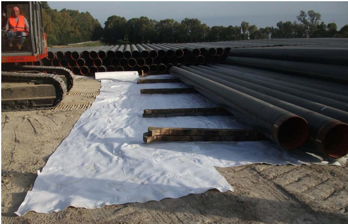
Fig. 7.1 - Piazzola di accatastamento tubazioni
