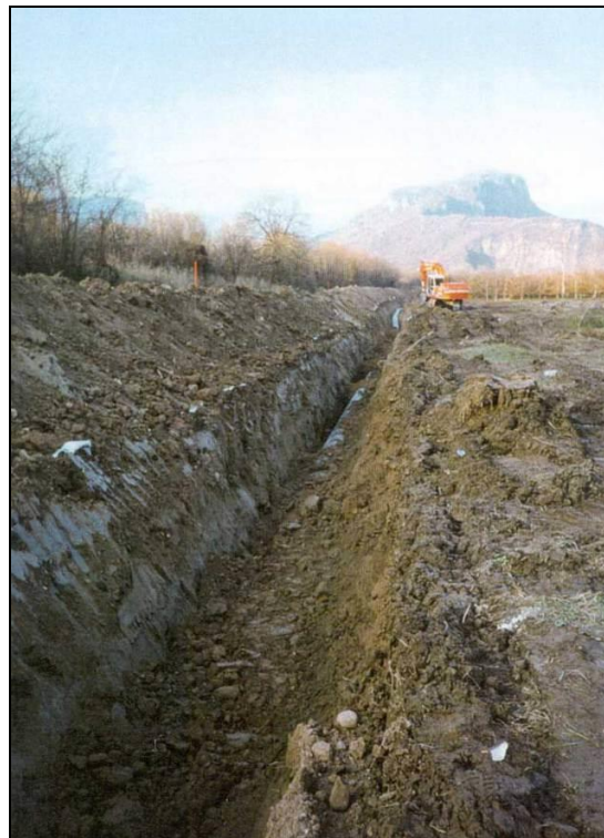
Fig. 7.5 - Operazione di rinterro della condotta
