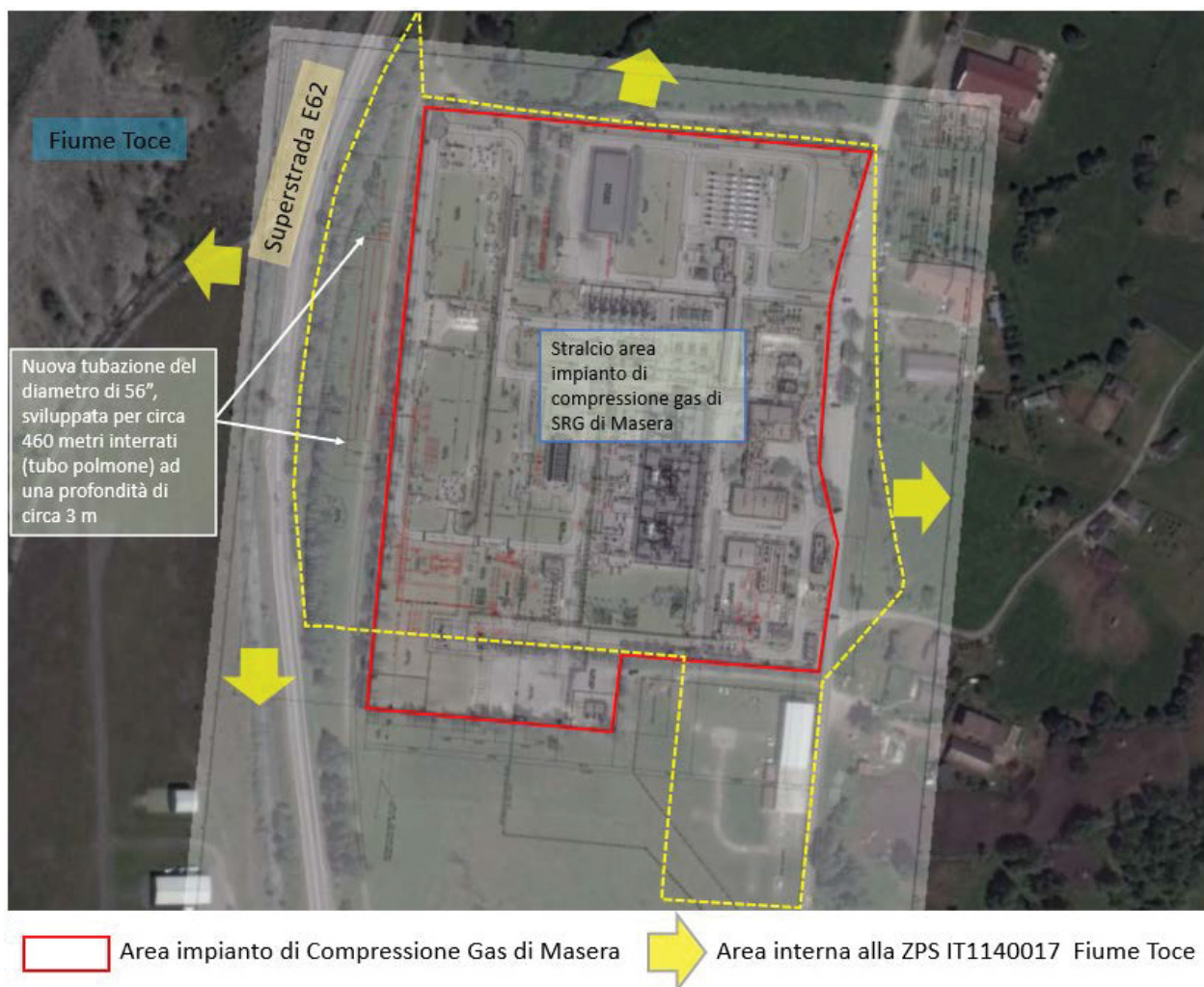
Figura 1.1-4: Ortofoto che illustra la relazione spaziale esistente tra l'Impianto di Compressione Gas di Masera e il perimetro della ZPS IT1140017 "Fiume Toce" - L'area al di fuori della linea tratteggiata in color giallo (perimetrazione ZPS da cartografia allegata al PRGC di Masera) è l'area della ZPS mentre l'area interna ne è esclusa; tutta l'area dell'impianto oggetto di adeguamento e il posizionamento della nuova tubazione diametro 56" (tubo polmone) sono poste al di fuori della ZPS IT1140017 Fiume Toce.
