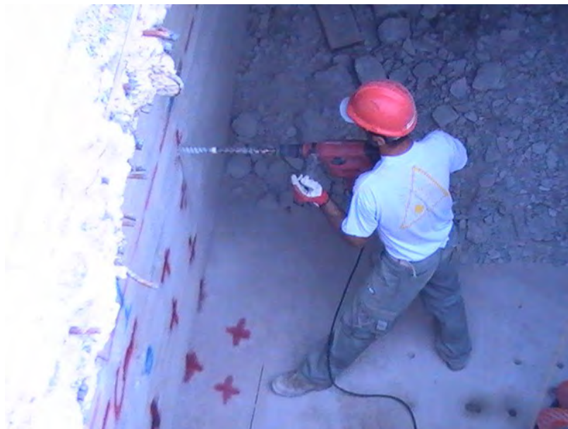
Perforazione con martello elettrico
