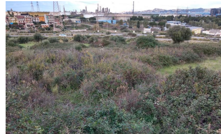
Fig. 4.1.: area vincolata attraversato dal tracciato del metanodotto
