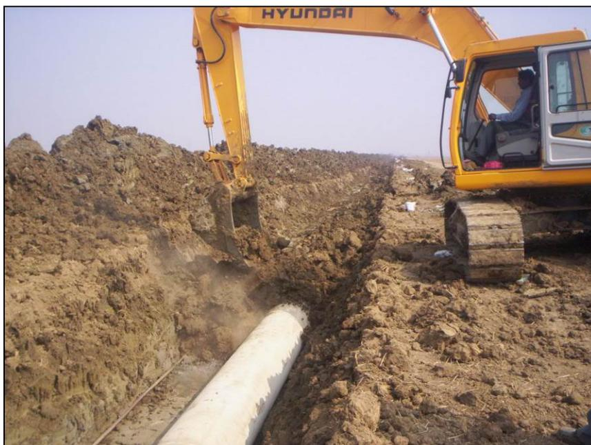
**Fig. 4.4/E: Rinterro della condotta**
