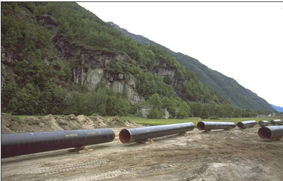
**Fig. 4.4/C: Sfilamento tubi**
