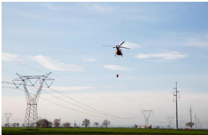
**Figura 3-8 Utilizzo dell'elicottero per la stesura della fune pilota**
