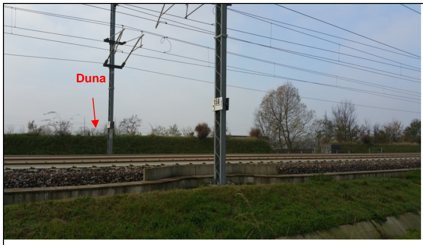
Figura 2 Corpo ferroviario nel tratto di indagine e presenza della Duna in terra sul lato Autostrada
