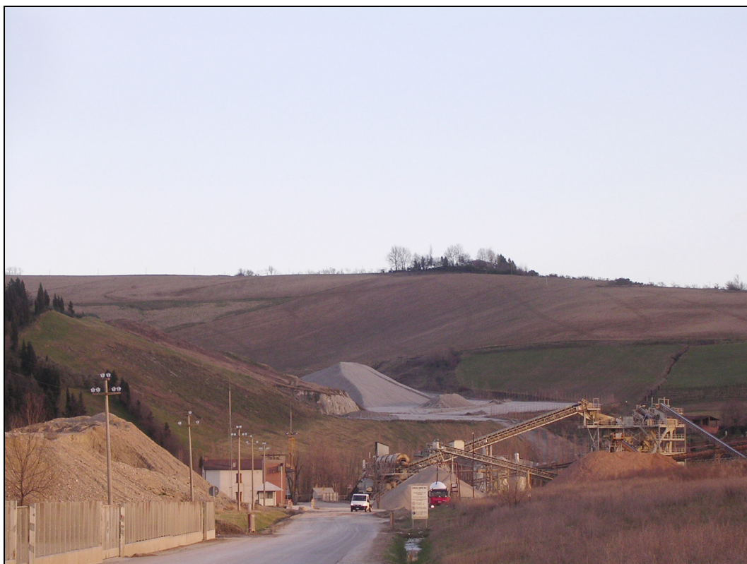
Figura 4.6-2: La cava di sabbia e ghiaia in località Frantoio, sulla sponda sinistra del fiume
