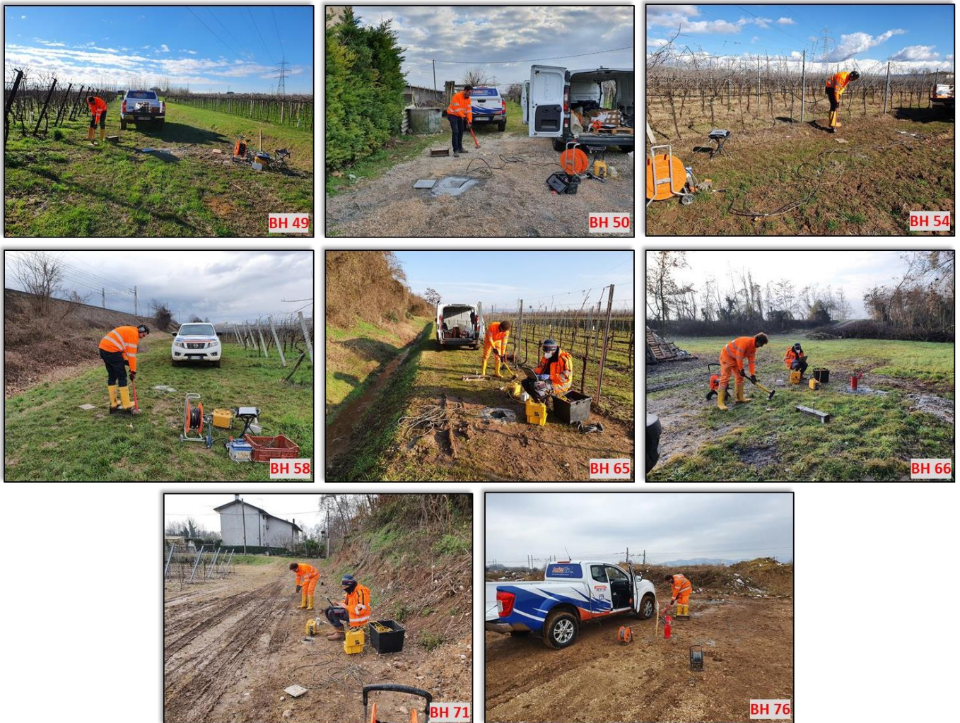
Figura 7 - Fasi di acquisizione
