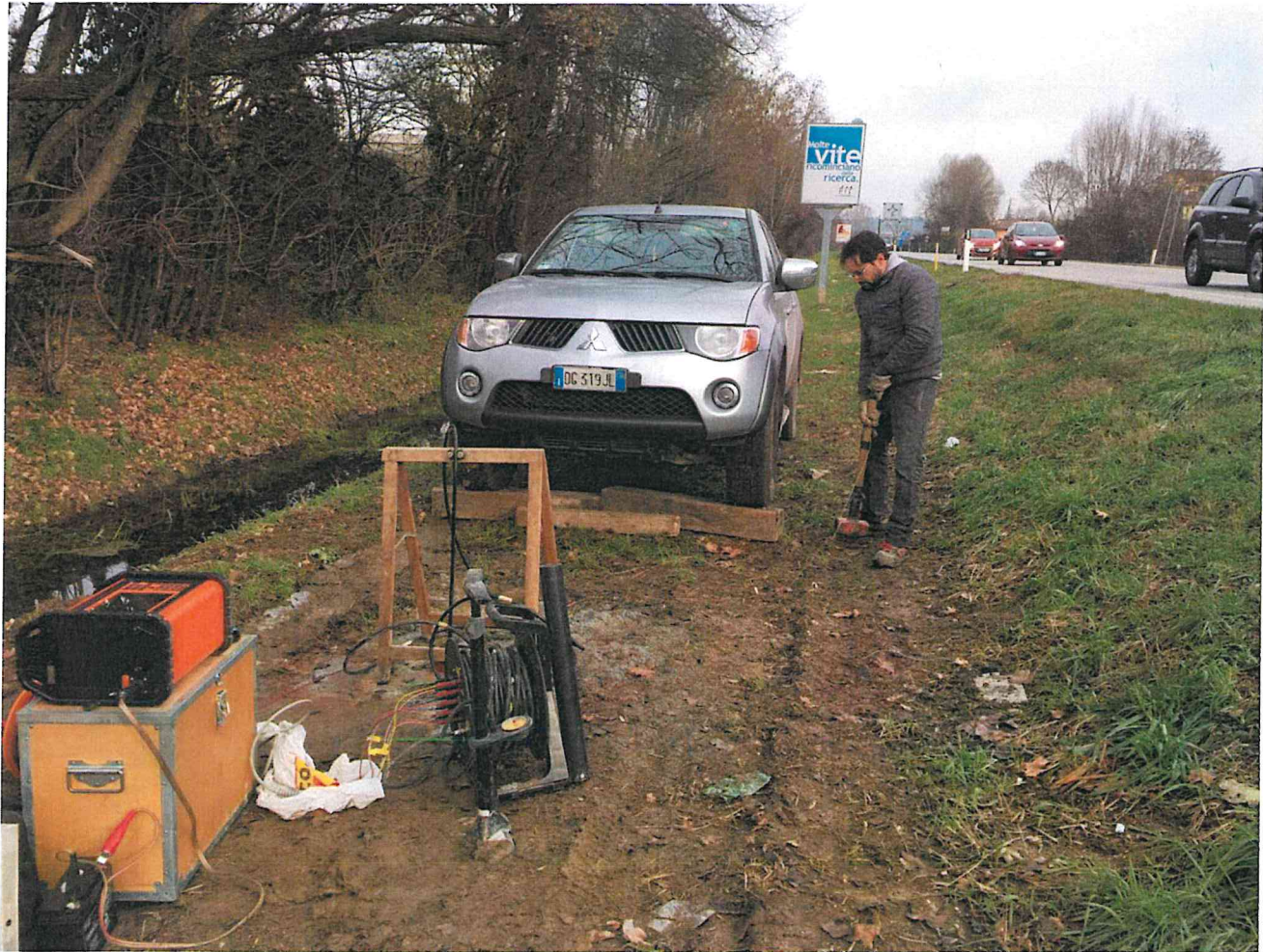
Piazzamento su BH93
