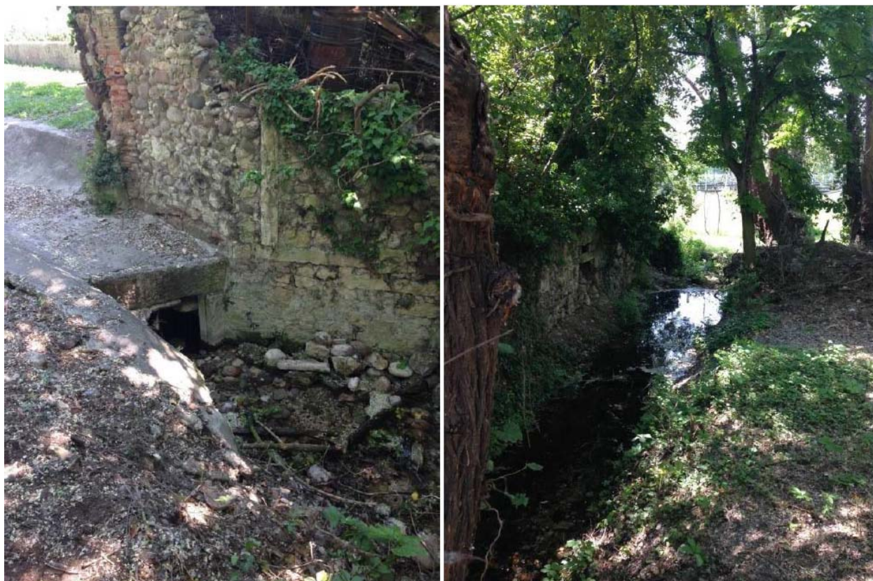
Figura 84 - “Fontanella delle monache”: canalizzazione in uscita dalla vasca verso il vicino “scolo Orti”.
