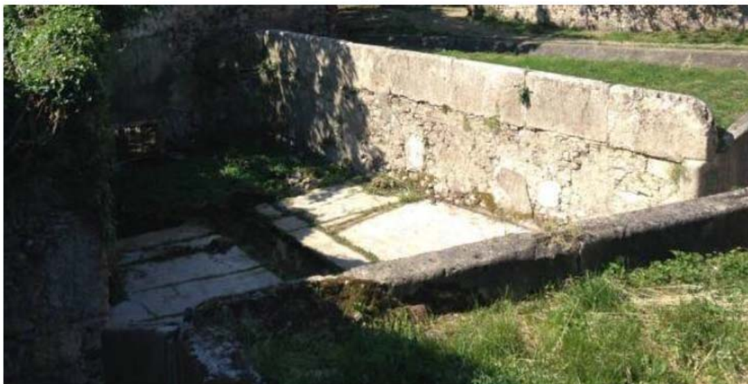
Figura 83 - “Fontanella delle monache”: vasca a pianta semi-triangolare e sezione di uscita.
