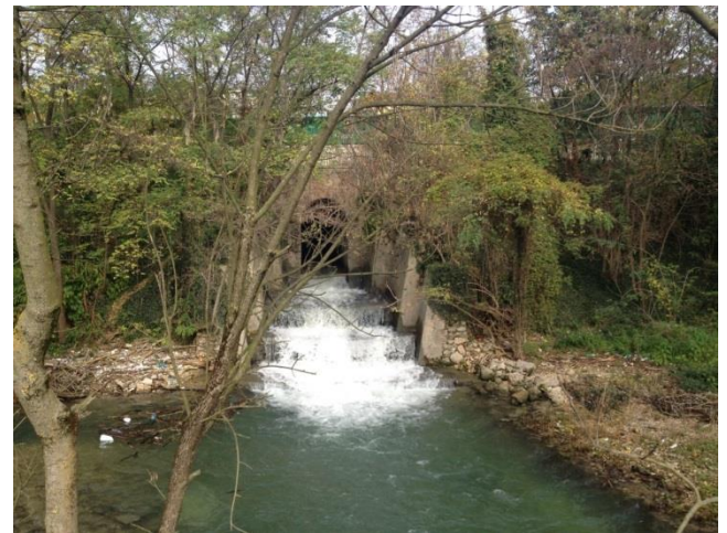
Figura 10.2 Torrente Valpantena – Tratto tombinato e fine del tombino a valle della linea ferroviaria esistente
