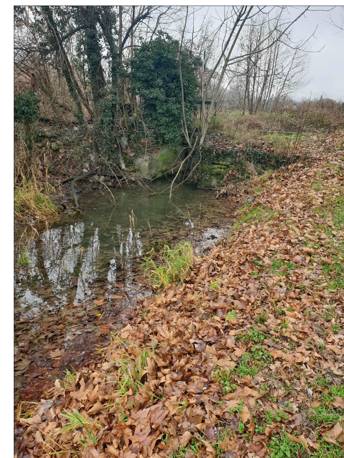
OPERA n° 29 FOTO LATO VALLE
