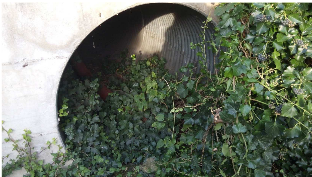
Figura 3 - Attraversamento Linea Storica Fosso B
