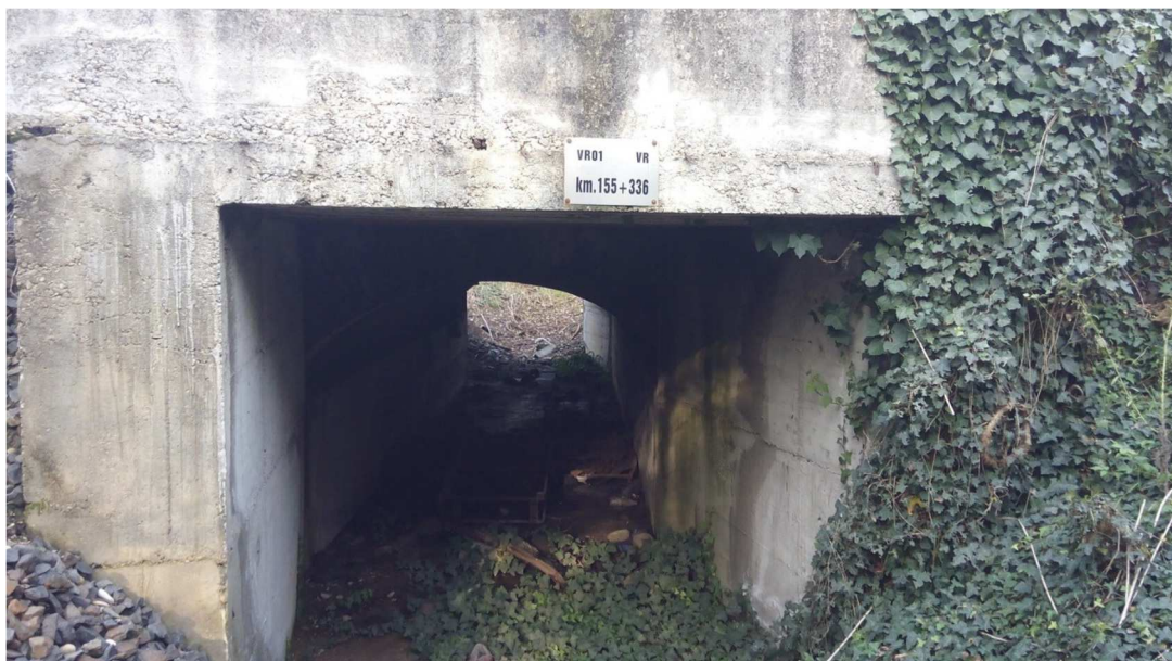
Figura 2 - Attraversamento Linea Storica Fosso Mattanara
