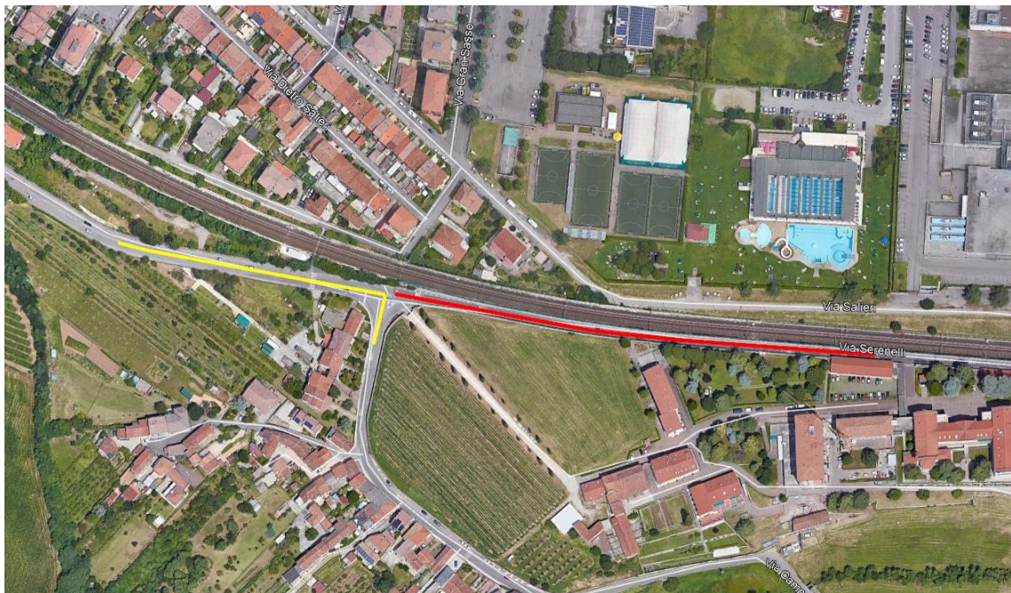
Figura 1: Stato di fatto
