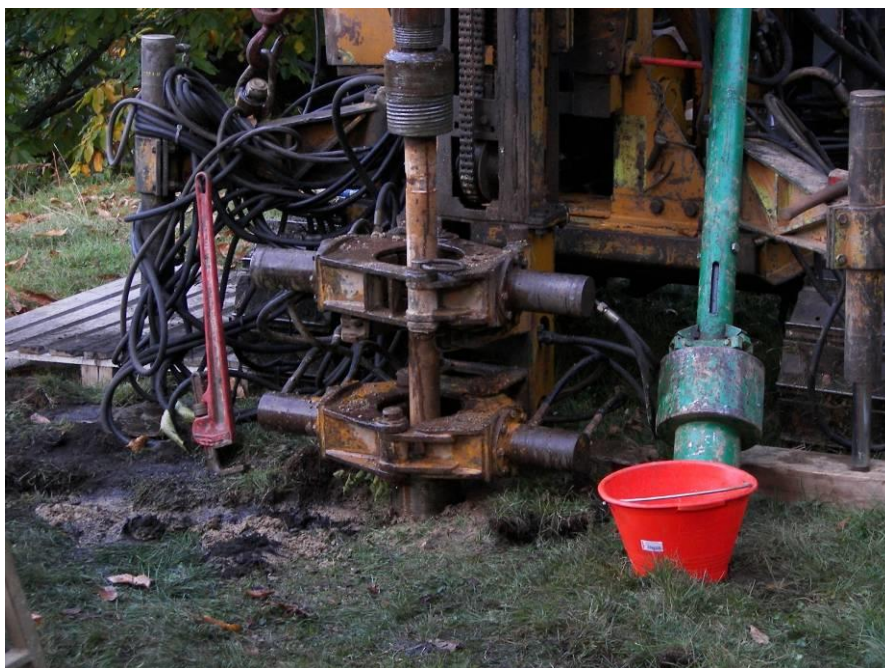
Figura 25 - Macchina operatrice per la realizzazione di micropali tubfix; sistema di scavo a rotopercussione
