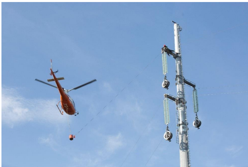
Figura 35 - Utilizzo dell'elicottero per la stesura della fune pilota. Si noti il particolare delle carrucole
