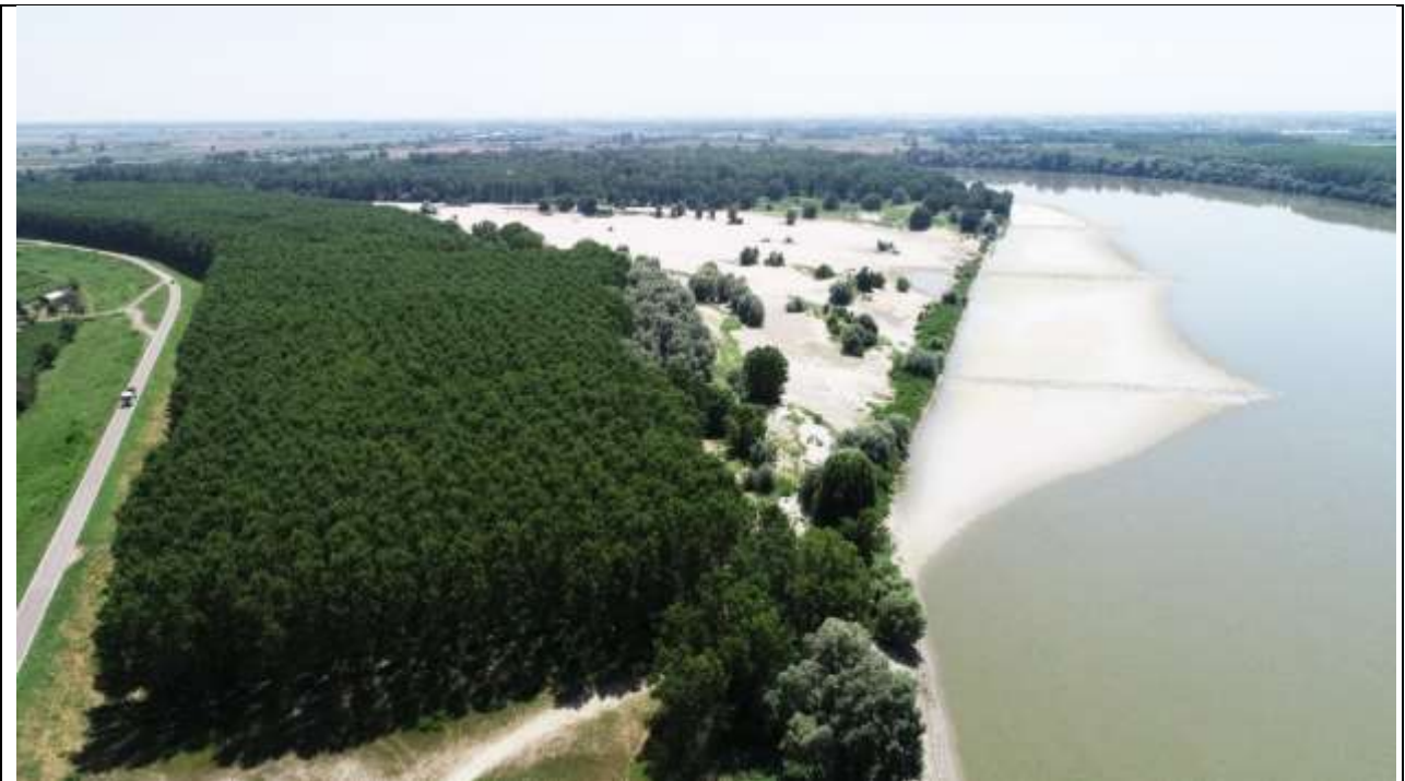
Figura 14 – Scenario evolutivo a lungo termine – Vista del fiume con portata inferiore a 800 m 3 /s
