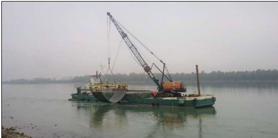
Figura 4 – Immagine di varo di teli filtranti zavorrati mediante apposita gru con telaio di varo
