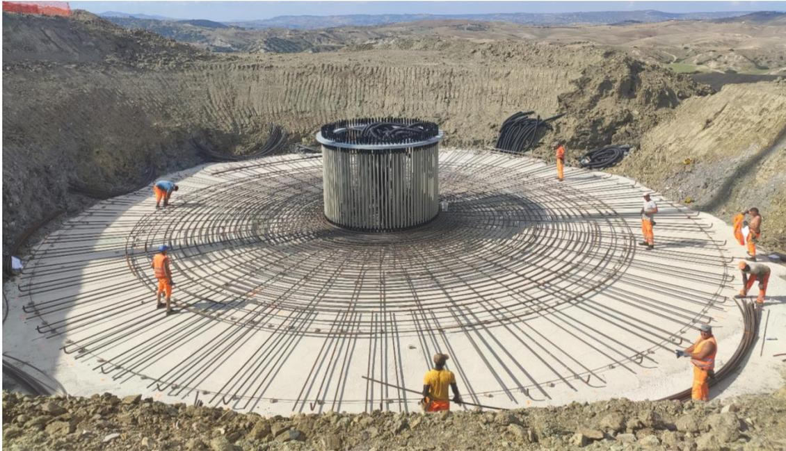
**Figura 4-4: immagine tipo posa anchor cages**
