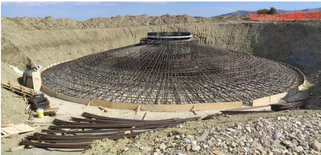
**Figura 4-5: immagine tipo armature plinto**
