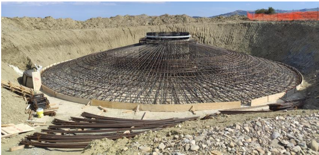
Figura 3-8: immagine tipo armature plinto
