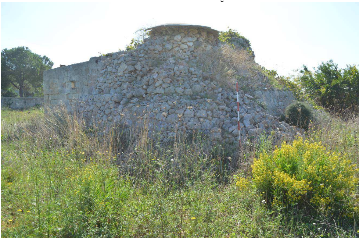
Rudere all'interno dell'area del CP Bari San Giorgio
