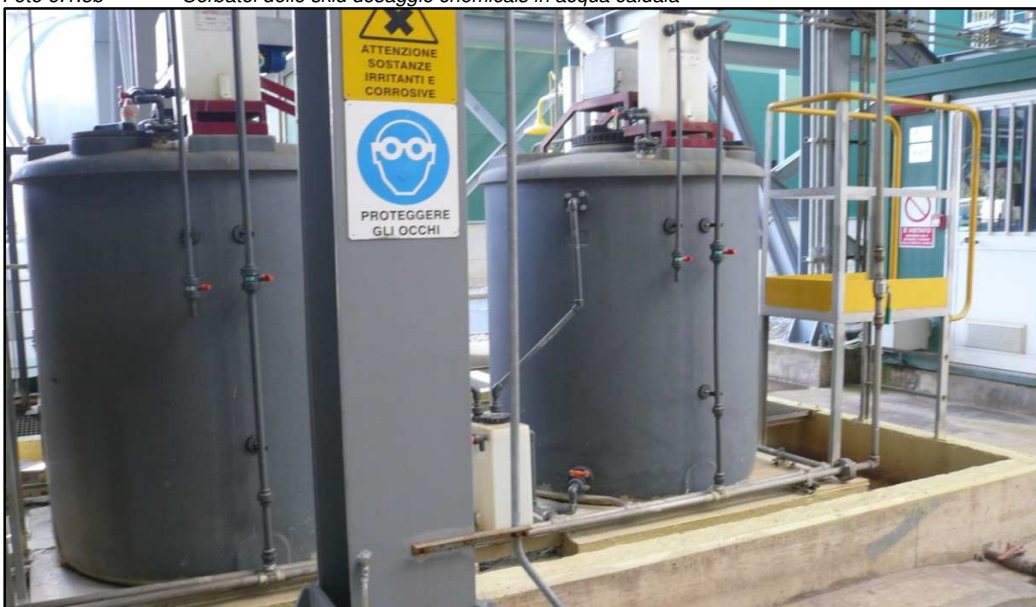
Foto 6.1.3b Serbatoi dello skid dosaggio chemicals in acqua caldaia
