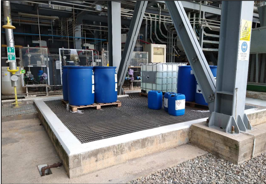
Foto 6.1.3b Serbatoi dello skid dosaggio chemicals in acqua caldaia
